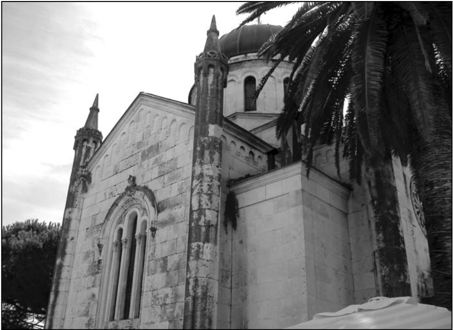
Слика 4: Део северозападне фасаде Цркве
