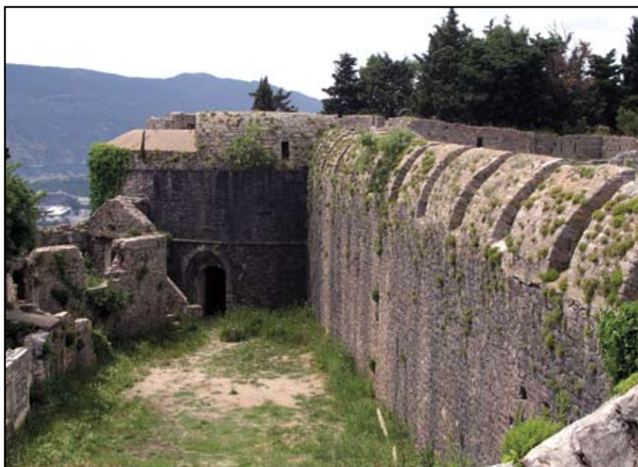
Сл. 2. Тврђава Шпањола, јужни сектор
