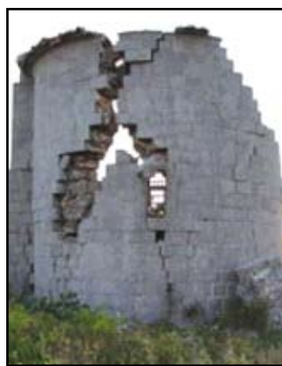
Поглед на цркву са истока, (јун 2007. г.)
