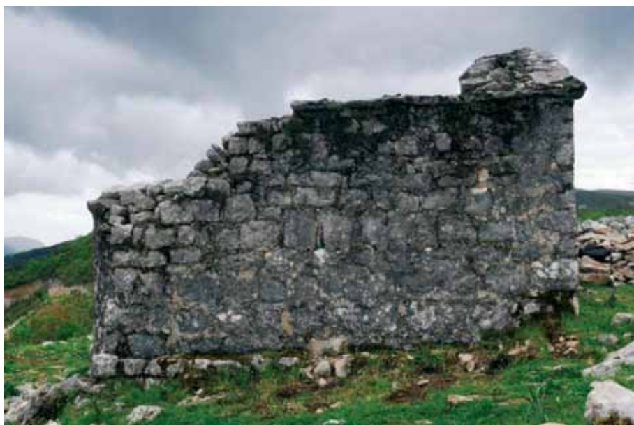
Сл. 9 - Изглед сјеверне фасаде цркве, прије радова
