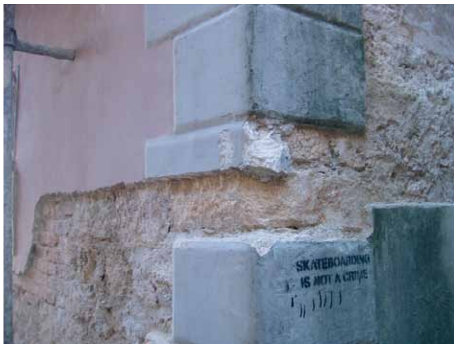
Sonda na sjeveroistočnom uglu prvobitne kule nad gradskim vratima
