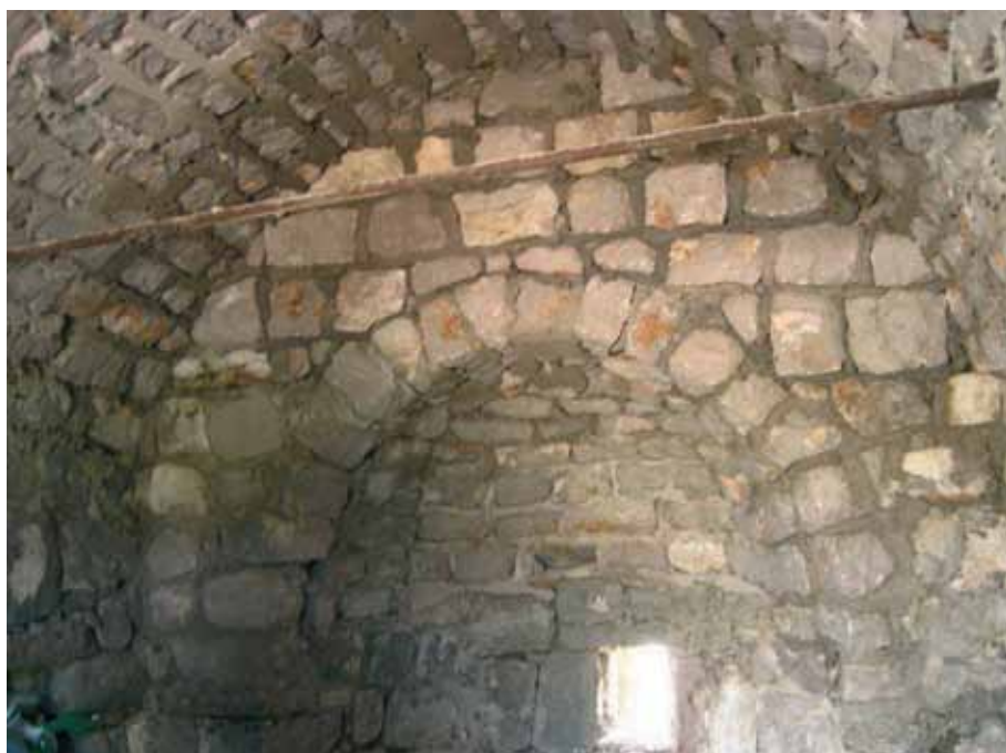
Сл. 18 - Изглед унутрашње стране реконструисане калоте апсиде источног зида цркве, током радова
