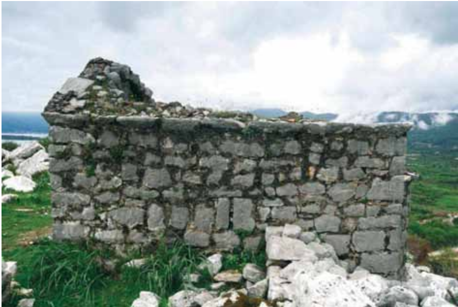
Сл. 11 - Изглед јужне фасаде цркве, прије радова
