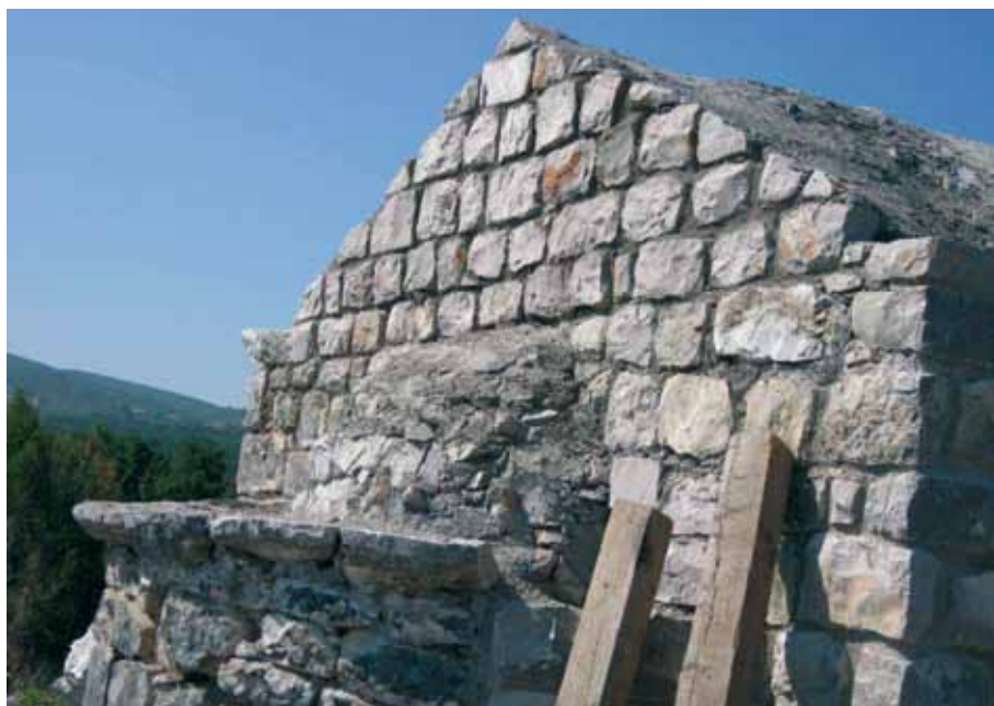
Сл. 17 - Изглед реконструисаног источног зида цркве, током радова
