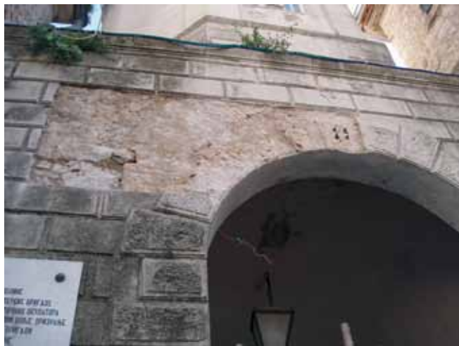
Sonda na sjevernoj strani lučnog dijela otvora (zapadna fasada)
