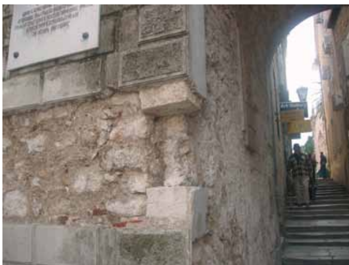
Sonda u dijelu naknadne ispune ivice lučnog otvora gradskih vrata
