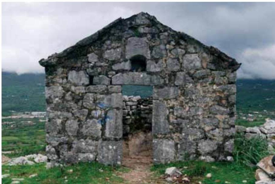
Сл. 8 - Изглед западне фасаде цркве, прије радова
