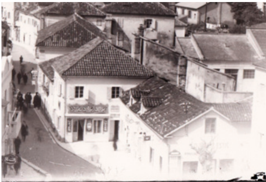
Sl. 2 Pogled na Njegoševu ulicu sa kućom Nikićjevića na vrhu padine; poč. 20. v.
