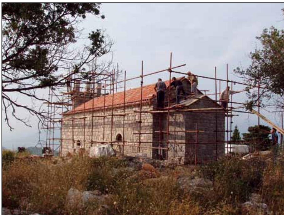
Sl. 10. Pogled sa jugoistoka u toku radova na pokrivanju krova
