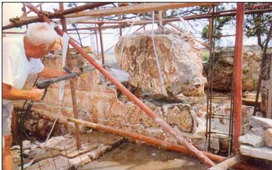
Sl. 9. Namještanje dijela srušenog južnog zida
