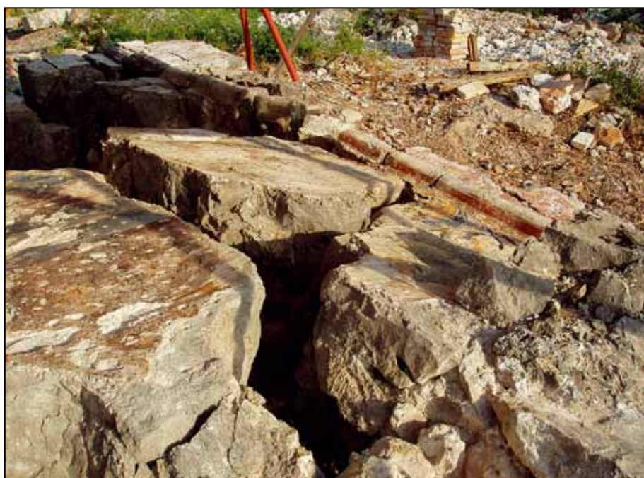
Sl. 6. Srušeni južni zid crkve
