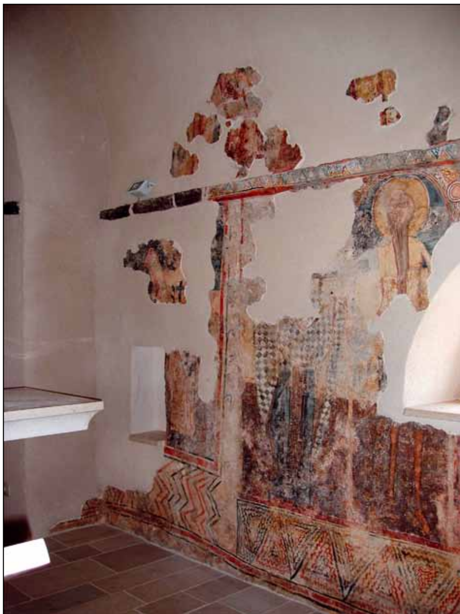
Sl. 14. Freske na južnom zidu, posle radova
