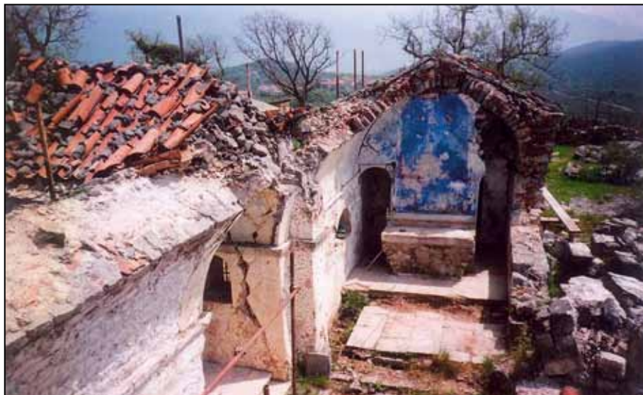
Sl. 2. Unutrašnjost crkve, prije početka radova (april 2004. g.)
