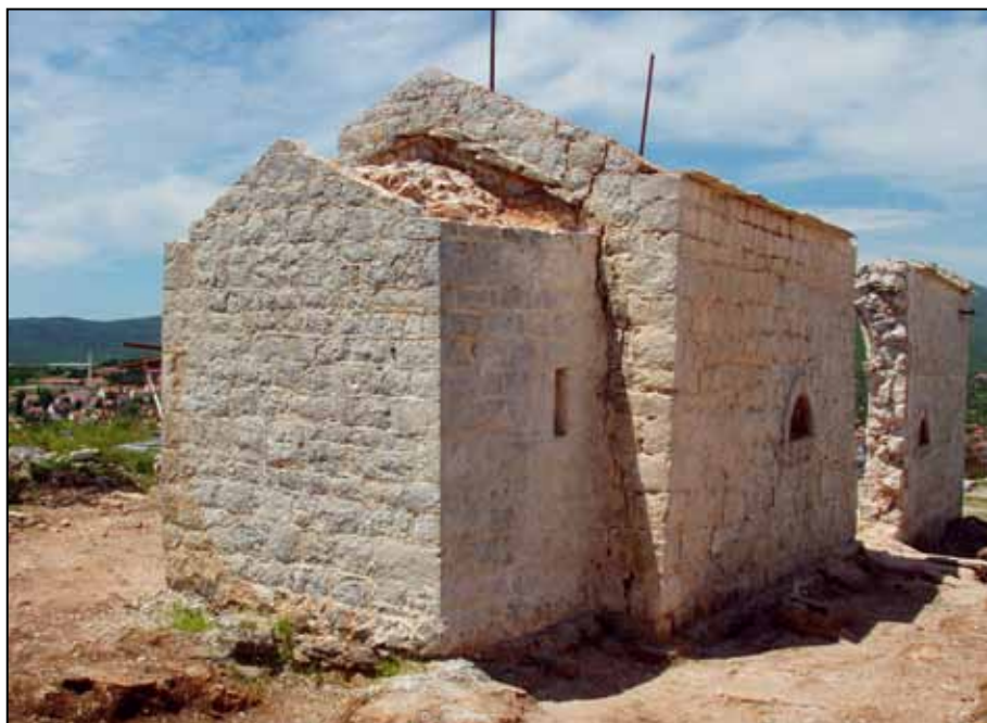
Sl. 7. Pogled sa sjeveroistoka, u toku radova
