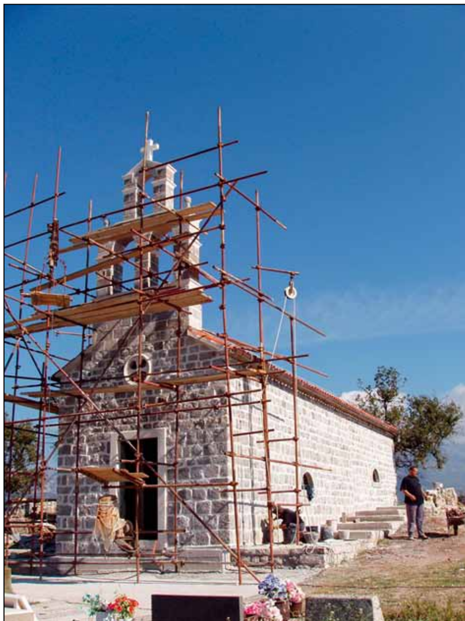
Sl. 11. Pogled sa jugoistoka, u toku radova
