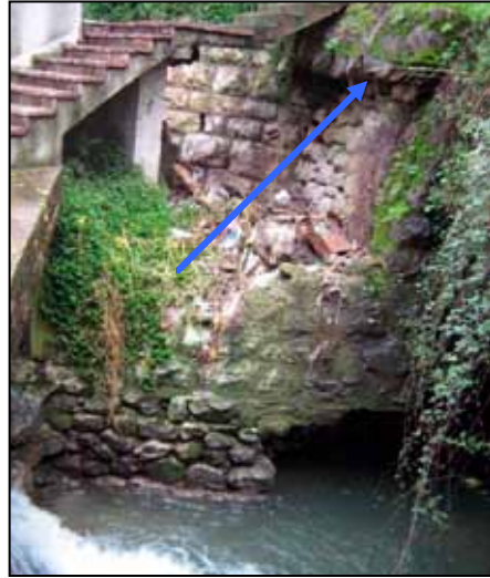
Слика 6. Остаци кегле насипа са подлоканим лијевим темељем
