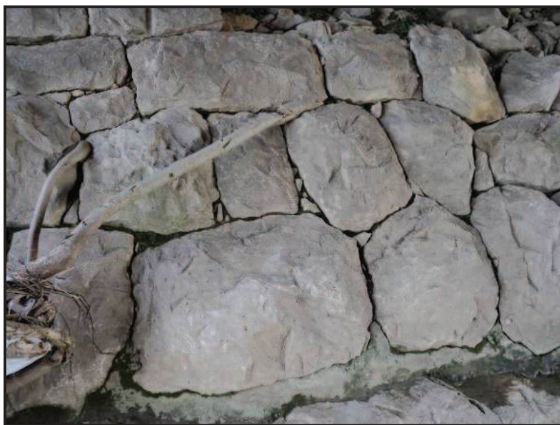
Сл. 5. Изглед унутрашње стране опорца
