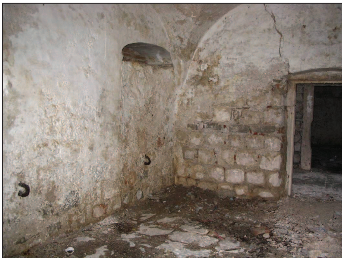
Sl. 14 Konoba u prizemlju i pogled na zazidana vrata
