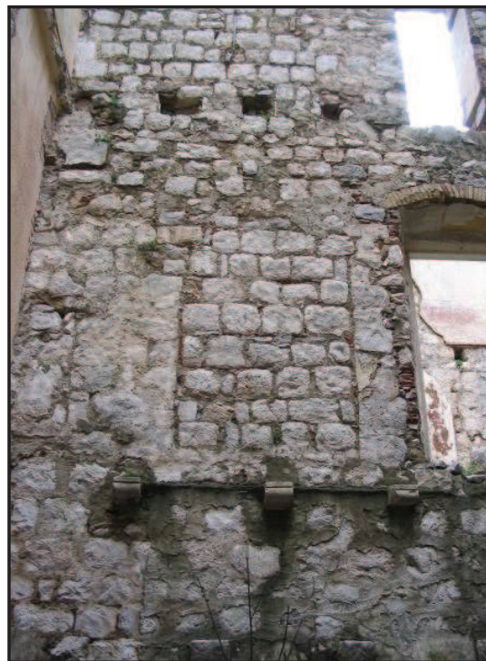
Sl. 5 Zazidani prozori stare kuće na zidu prema moru
