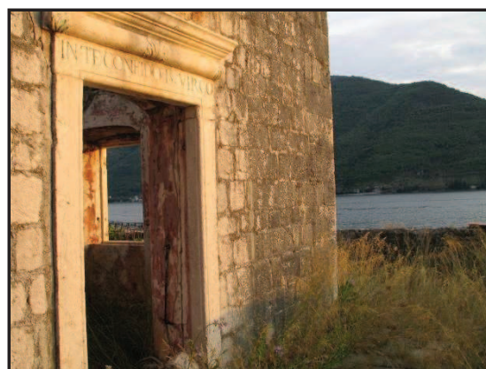
Sl. 22 Natpis na balkonskim vratima na zapadnoj fasadi
