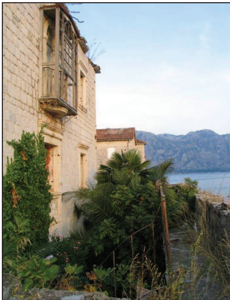
Sl. 12 Pogled na fasadu prema moru i vrt ispred palate
