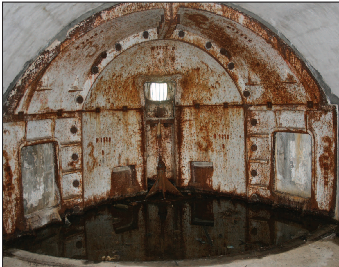
Sl. 17. Čelična kupola haubice 120 mm, for Goražda
