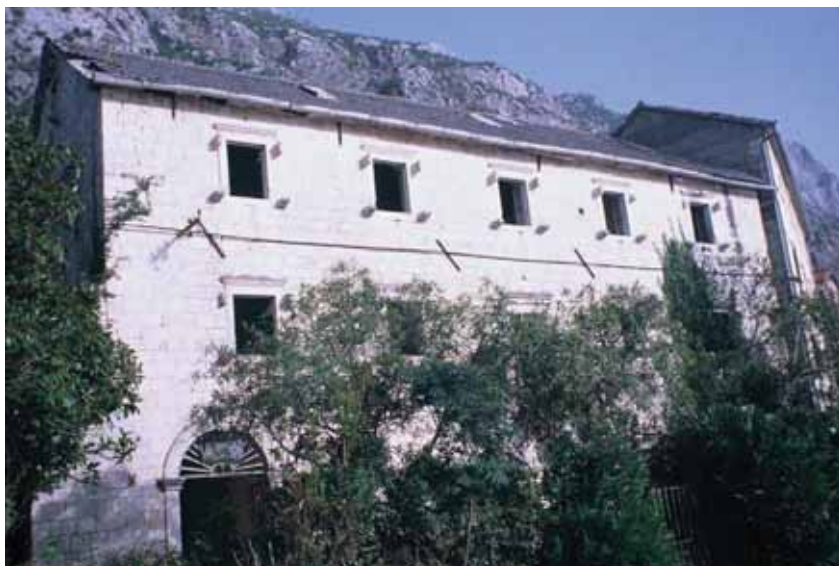
Slika 19 - palata Radimiri, Dobrota-Kotor, XVII v. stanje prije sanacije i adaptacije
