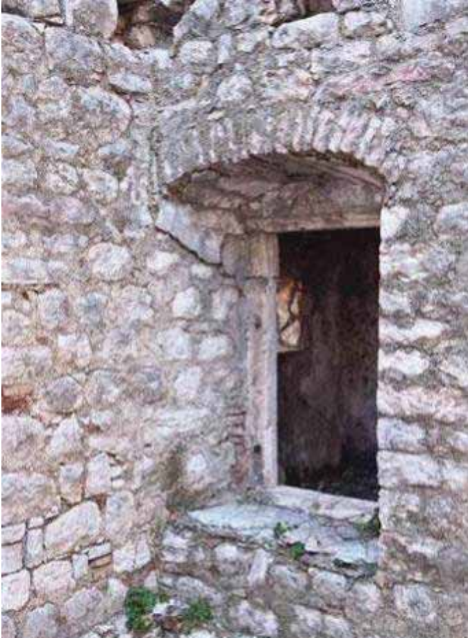
Изглед улаза у анекс уз сјеверо-западни угао куће
