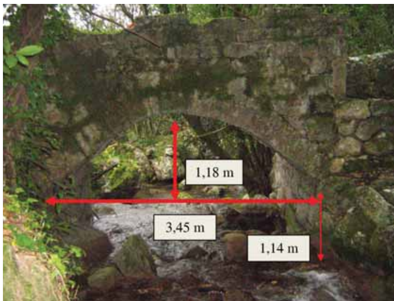
Слика 5 - Мост са основним димензијама, узводна визура
