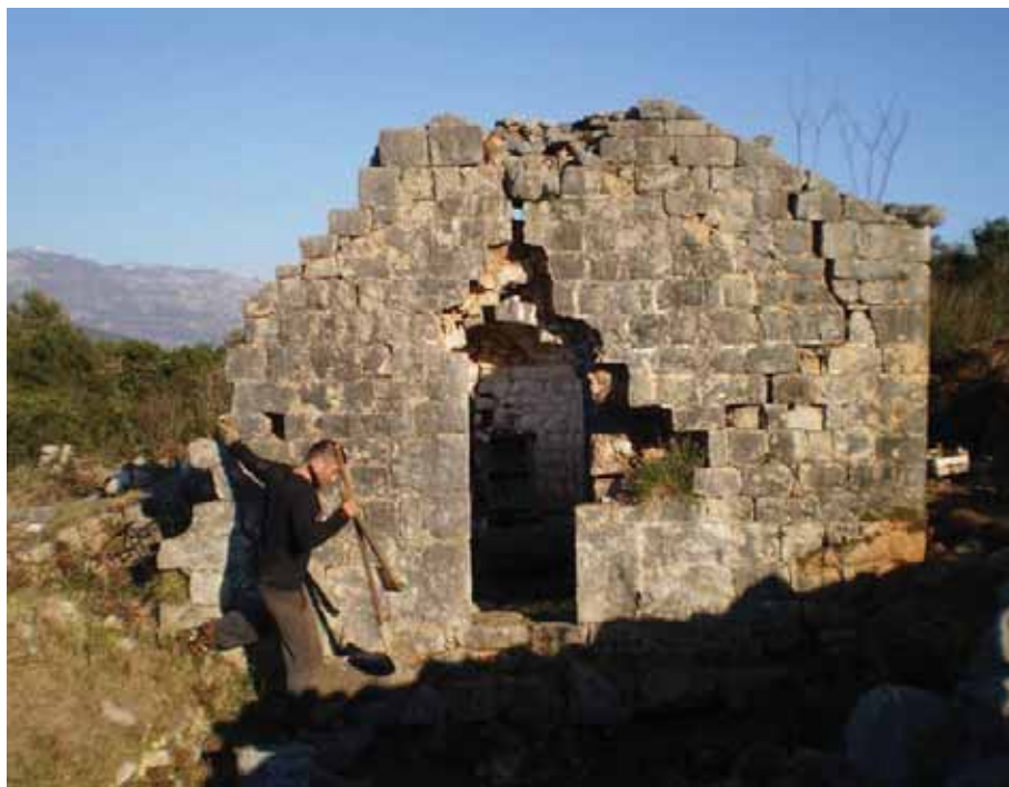
Сл. 4 - Поглед на западну фасаду цркве, 2011. године
