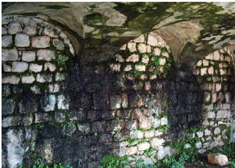
Slika 1 - Detalji veze zida sa svodom u lođi, prije radova
