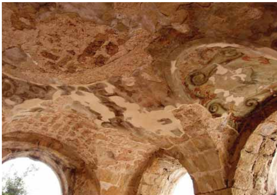
Slika 3 - Detalj svoda u toku radova
