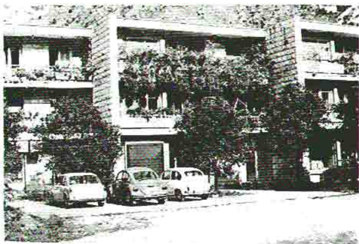
Sl. 1. ...i ova je delo zelenila naselja, Stambena zgrada, moji delo, Kotor
