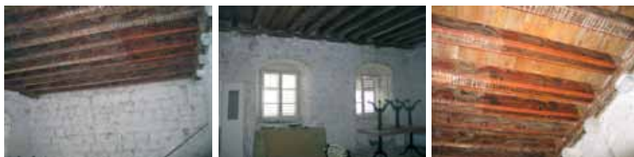
Slikane drvene grede sa profilacijom "na baštun" u Palati Štukanović
