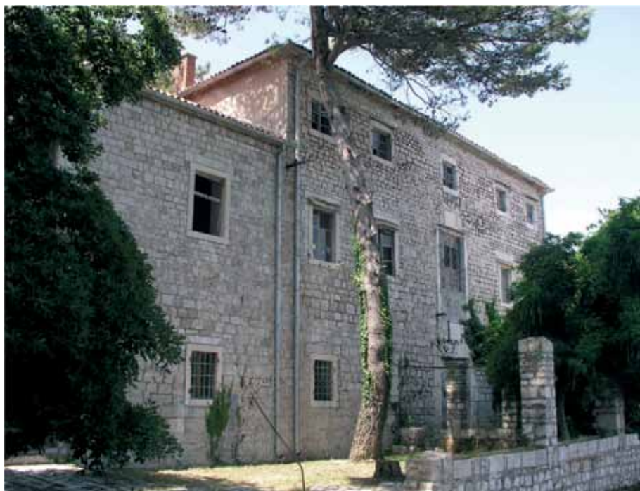
Sl. 12. Lazaret u Meljinama, izgled prema moru
