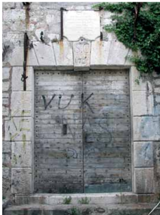
Sl. 15. Lazaret u Meljinama, ulazni portal
