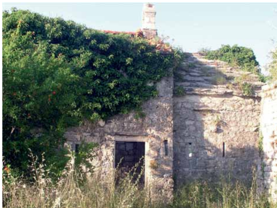
Sl.6. Utvrđenje na Verigama, crkva i objekat straže
