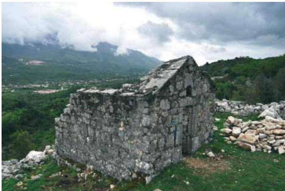
Сл. 3 - Изглед цркве и њен положај у односу на Грбаљско поље, поглед са сјеверозапада, прије радова
