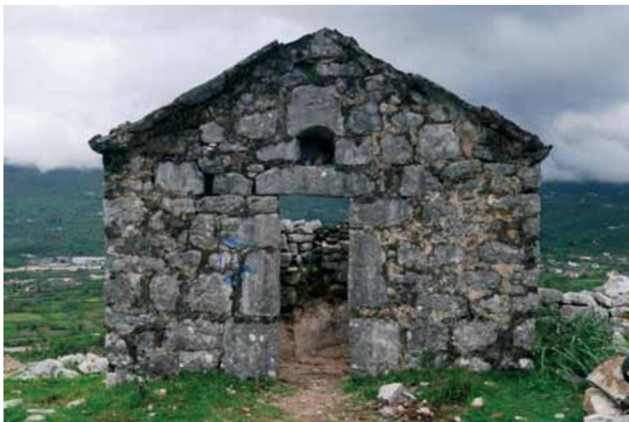
Сл. 8 - Изглед западне фасаде цркве, прије радова
