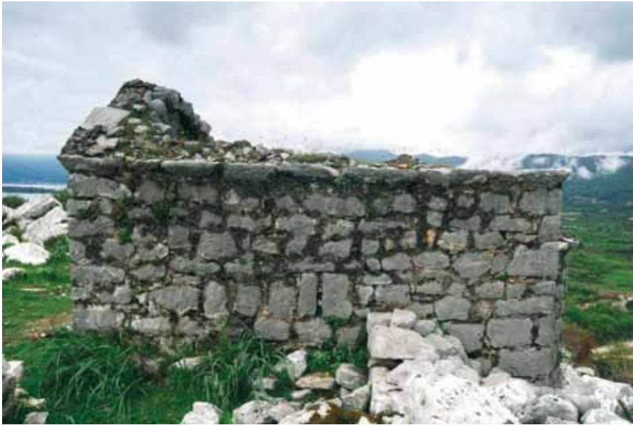
Сл. 11 - Изглед јужне фасаде цркве, прије радова
