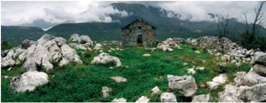
Сл. 2 - Изглед цркве и црквеног дворишта, прије радова (снимио С. Красан, 2008.г. 8 )
