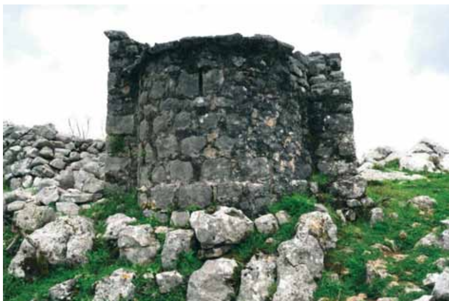
Сл. 10 - Изглед источне фасаде цркве, прије радова
