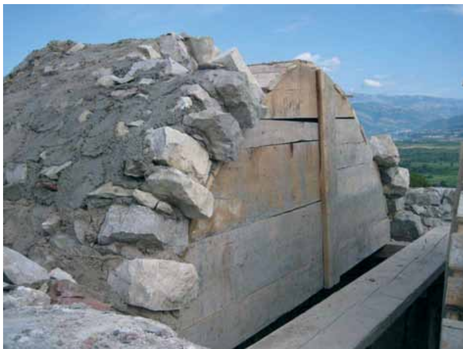
Сл. 15 - Реконструкција свода, током радова
