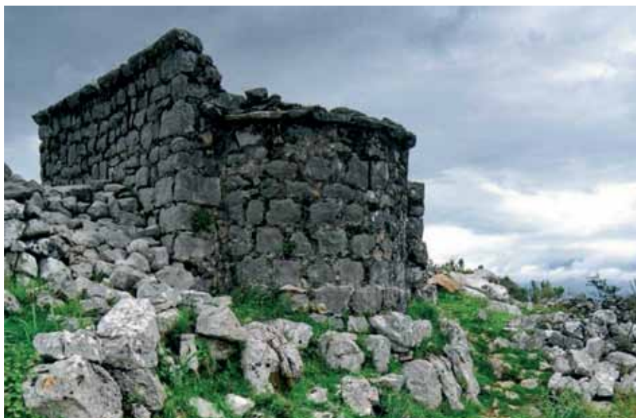
Сл. 5 - Изглед цркве, поглед са југоистока, прије радова
