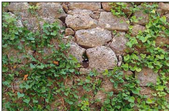
Sl. 12.- Kula u Trebesinu, puškarnica u sjevernom zidu
