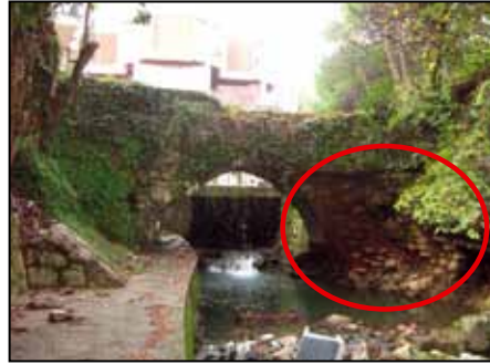
Слика 5. Изглед мосӣ са низводне (зајадне) сѣране са заокруженим ошћећеним лијевим ојорцем
