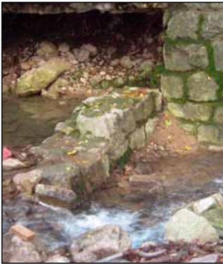
Слика 6. Ошћећење каскаде и дна кориџа њојока (са сѣране се види дио лијевог ојорца)
