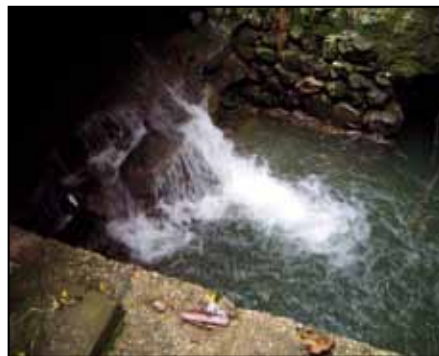
Слика 8. Слабијије Љубић јојока, пред мостом, које ошћећује дно корића
