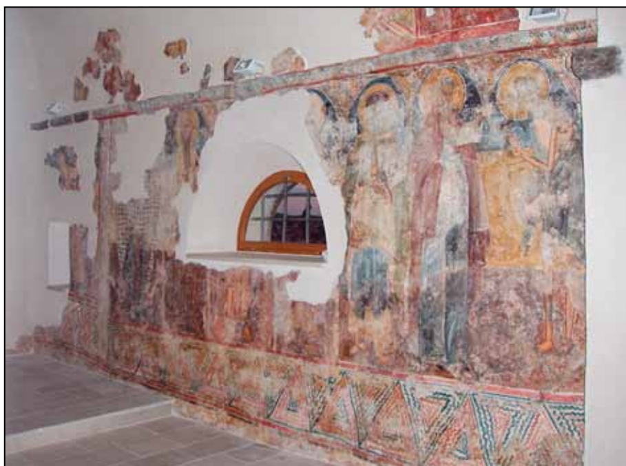
Sl. 16. Izgled južnog zida nakon restauracije
