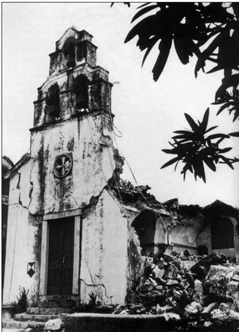
Sl. 1. Crkva sv. Ivana - oštećenja od zemljotresa
