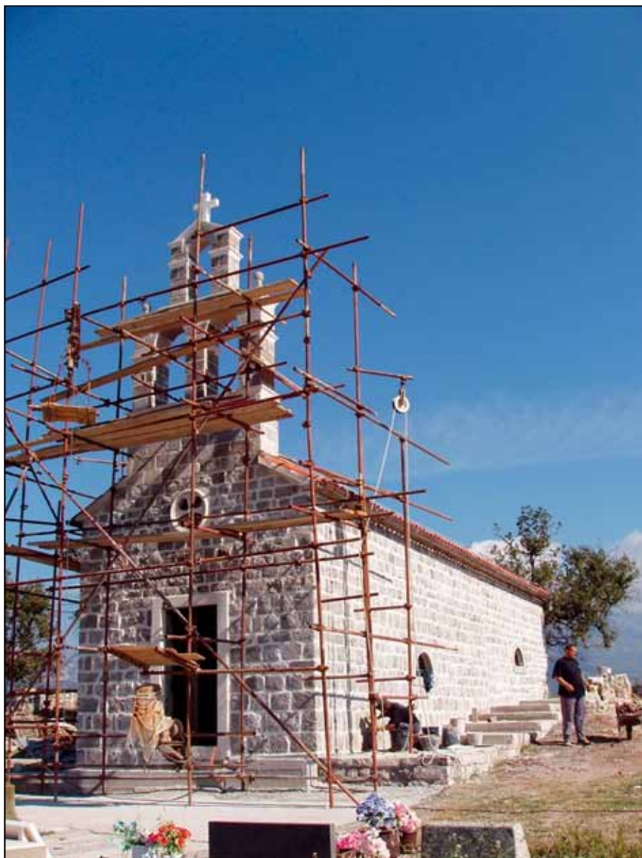
Sl. 11. Pogled sa jugoistoka, u toku radova
