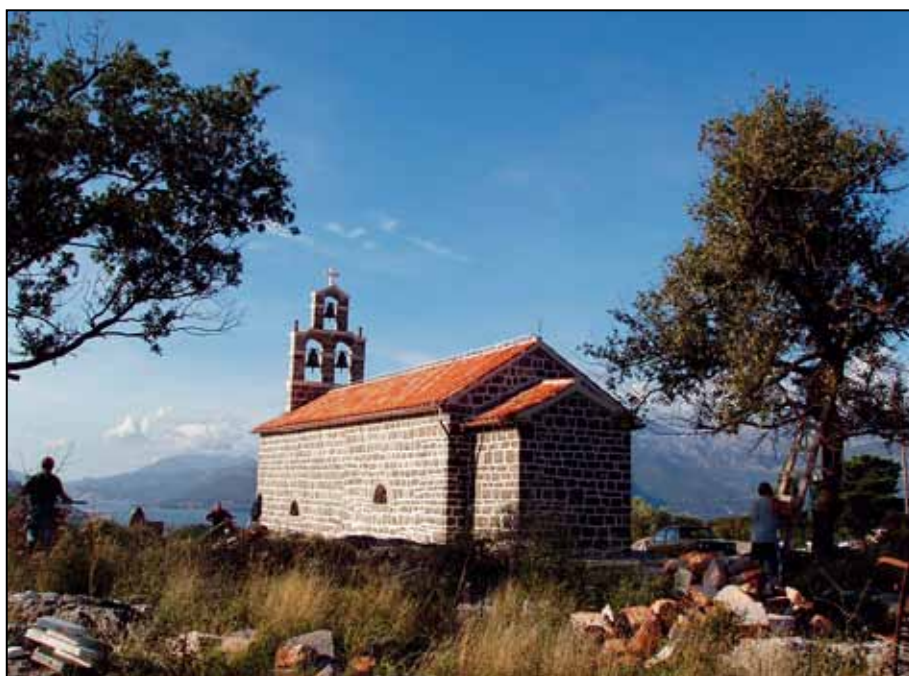
Sl. 13. Pogled sa jugoistoka, posle radova
