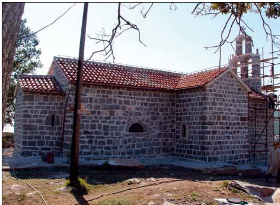
Sl. 12. Pogled sa sjeverne strane, u toku radova
