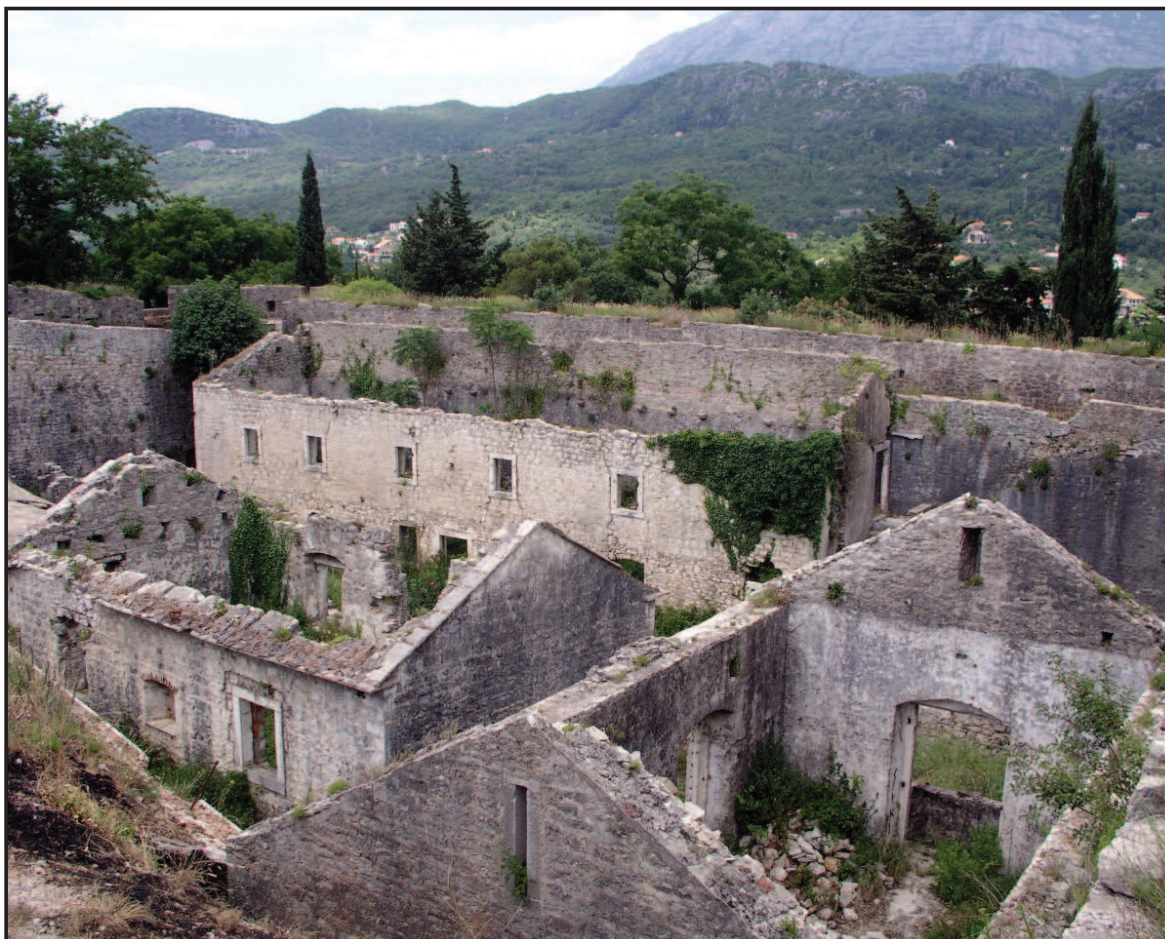
Sl. 9. Tvrđava Španjola, objekti u unutrašnjosti tvrđave
