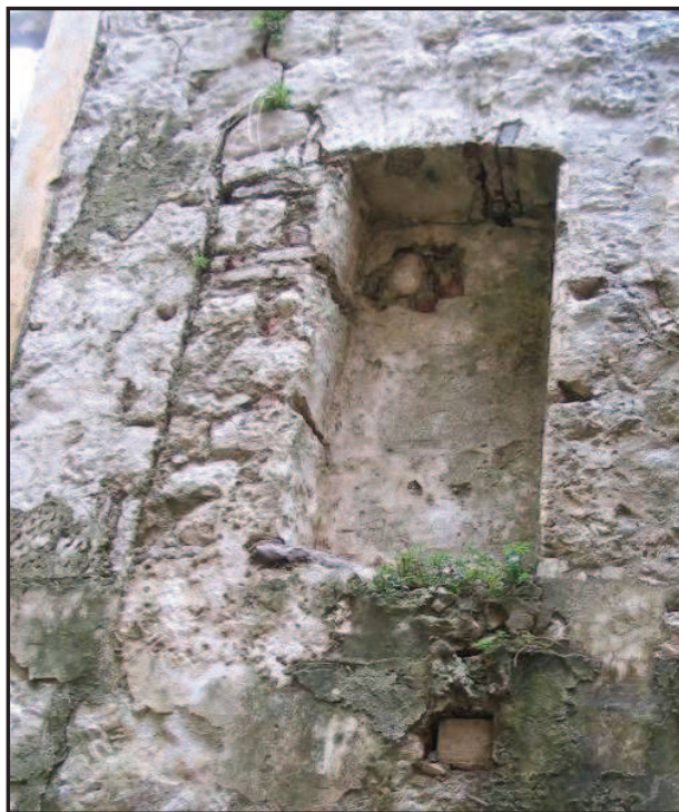
Sl. 4 Zazidan prozor u kalkanskom zidu stare kuće
