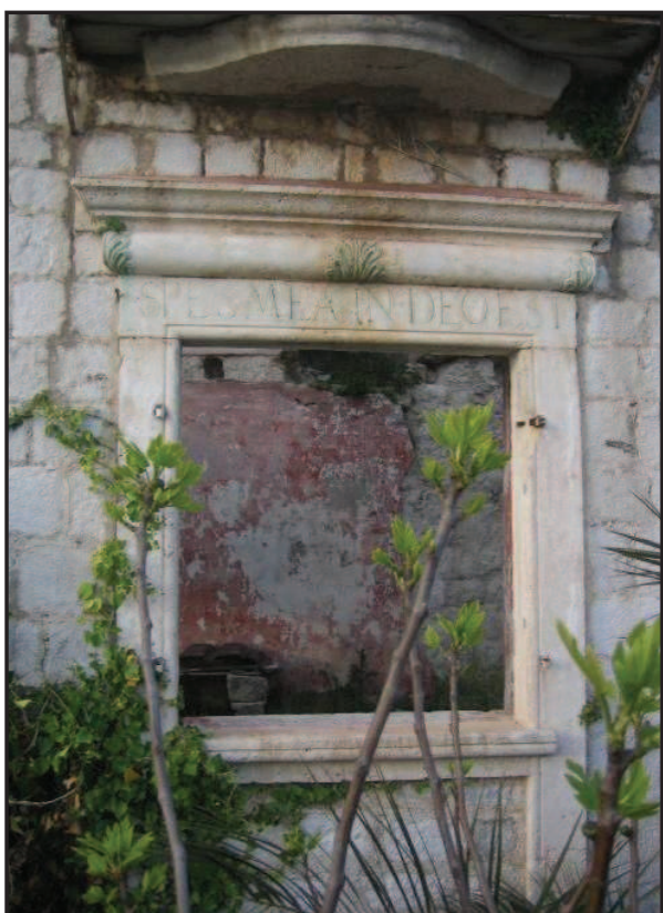
Sl. 21 Natpis na balkonskim vratima na fasadi prema moru
