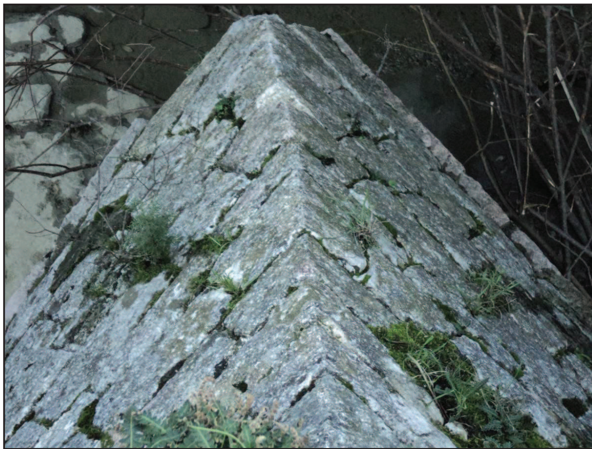
Сл. 8. Кљун средњег стуба, изглед са врха моста
