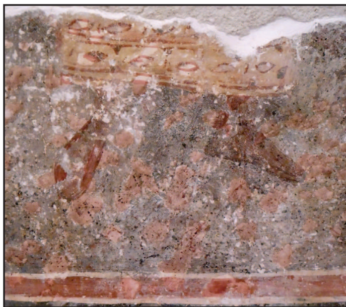
Sl. 9. Fragment s ostatkom freske na sjevernom zidu naosa (nakon probijanja prozora)
