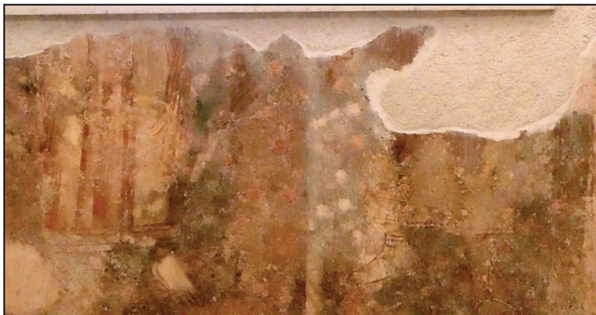
Sl. 6. Fragment s ostatkom fresaka na južnom zidu naosa (nakon probijanja prozora)
