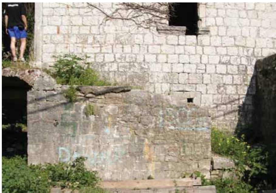
Изглед централног степеништа на главној фасади
