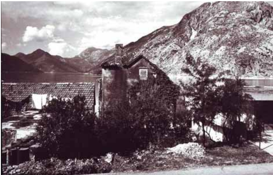
Изглед источне фасаде палате
