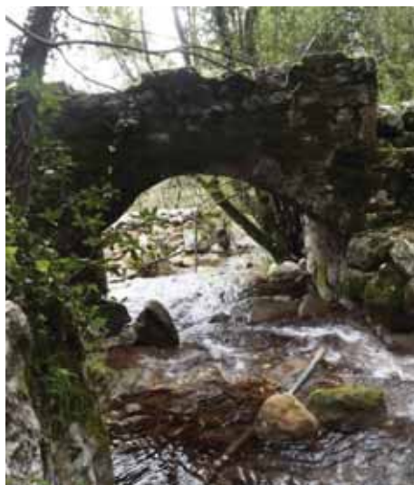
Слика 2 - Изглед моста са узводне стране
