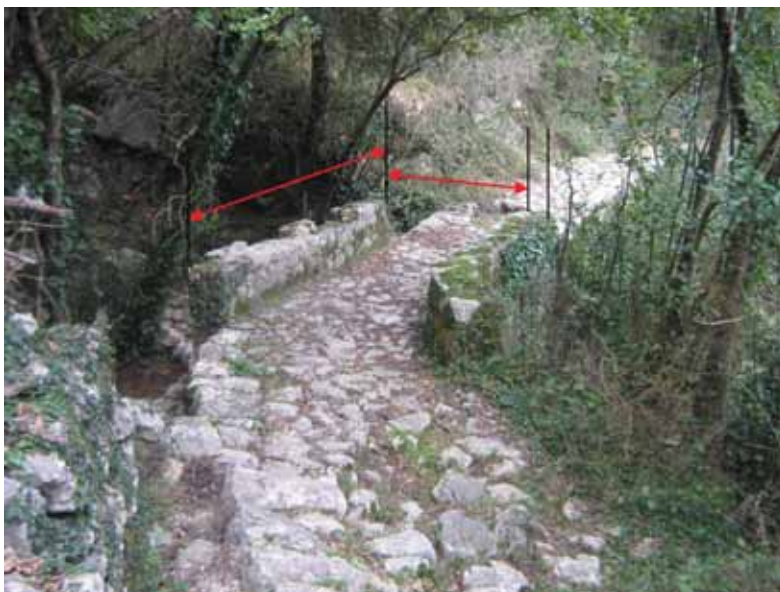
Слика 8 - Изглед пјешачког пута, камене калдрме, која пролази преко моста. Мост је на дијелу пута гдје су зидови од слаганог камена.
