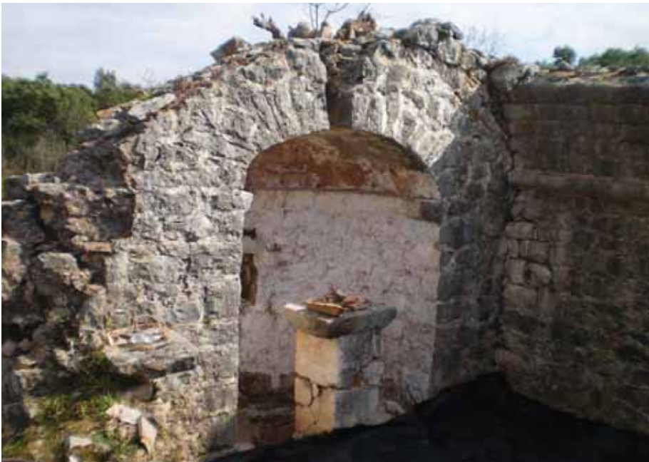
Сл. 18 - Поглед на унутрашњост апсиде после обијања малтера
