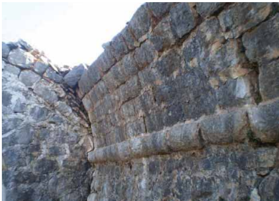
Сл. 8 - Унутрашњост цркве, југоисточни угао са линијом старијег крова на источном зиду и познијим сводом
