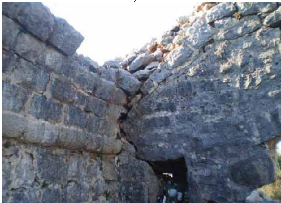
Сл. 9 - Унутрашњост цркве, југозападни угао; линија старијег двоводног крова на западном зиду, дограђени дио и познији свод
