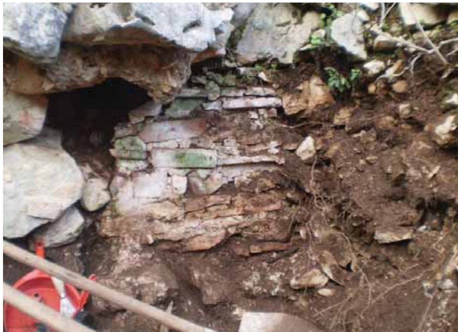
Сл. 15 - Изглед зидића испод сјеверног дијела апсиде
