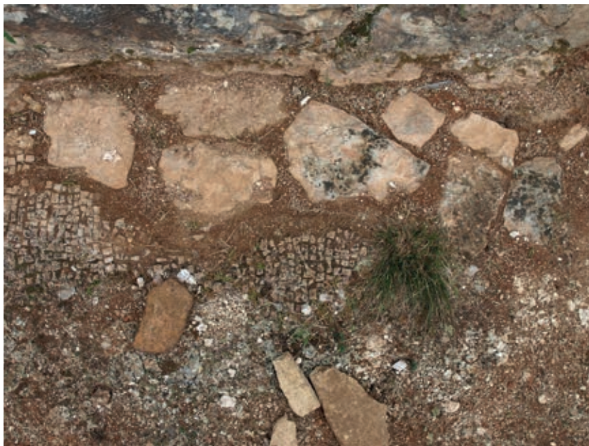
Sl. 6 - krpjenje oštećenja mozaika kamenim pločama duž južnog zida crkve
