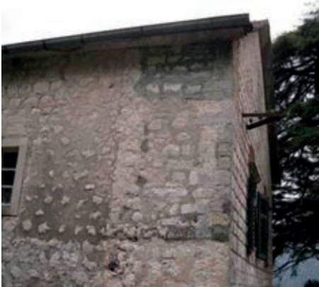
Ostatak zazidane ugaone vidionice na sjeveroistočnom uglu palacina
