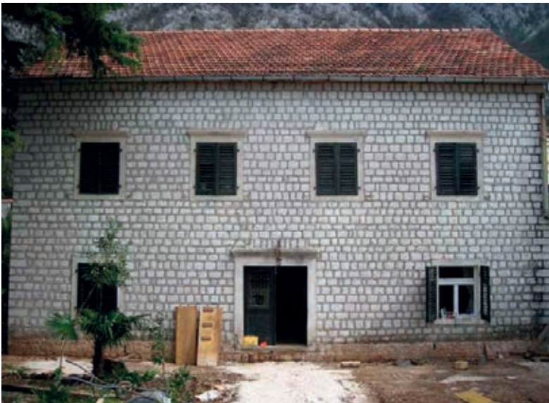
Izgled glavne fasade placina
