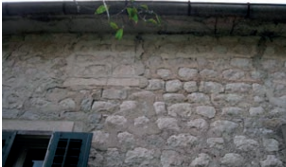
Ostatak zazidanog prozora u stepeništu na istočnoj fasadi palacina
