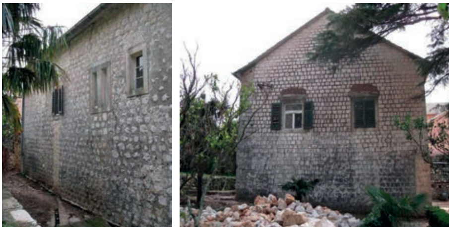
Izgled istočne i sjeverne fasade palacina
