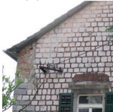
Ostatak zazidane ugaone vidionice na sjeveroistočnom uglu palacina
