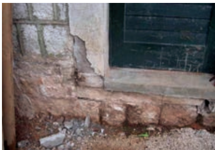
Izgled malterne sonde na glavnim vratima
