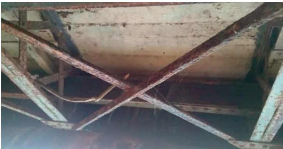
Изглед доњег хоризонталног спрега
