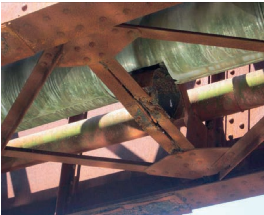
Хоризонтални спрег, љускање вертикале
