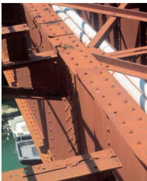
Попречни пресјек конзолног носача Изглед главног носача, површинска корозија, деформација лимова
