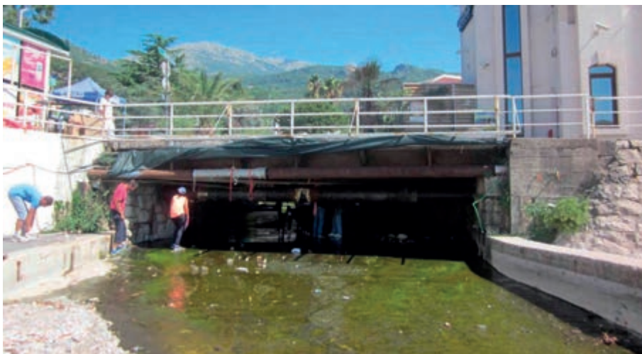
Изглед челичног (сада) пјешачког моста у Игалу, поглед са низводне стране
