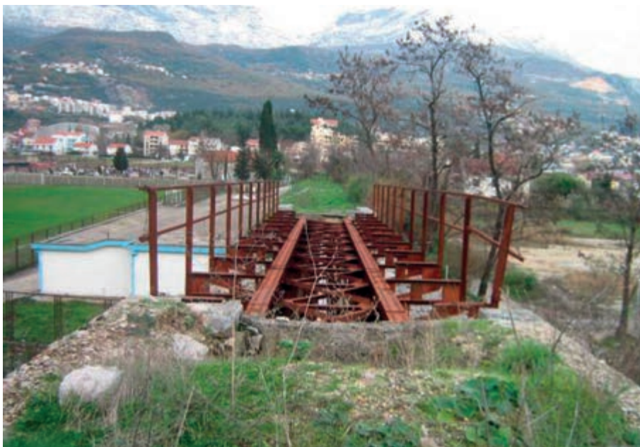
Изглед моста са жељезном конструкцијом
