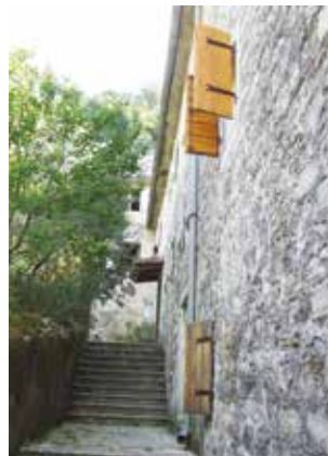
Slika 60. Spoljašnje stepenište nalazi se uz bočni zid kuće
