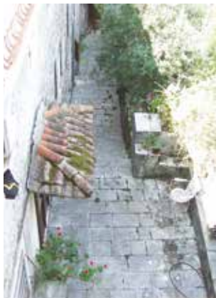
Slika 58. Podest sa proširenjem ispred glavnog ulaza u kuću
