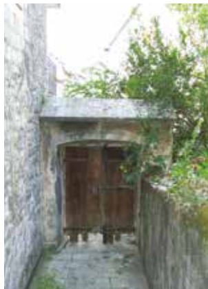
Slika 59. Ulazna kapija obezbeđena je sistemom reza i brava
