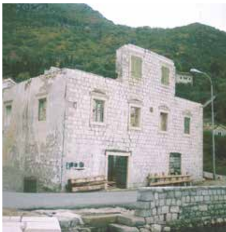
Slika 52. Izgled kuće pre i u početku obnove
