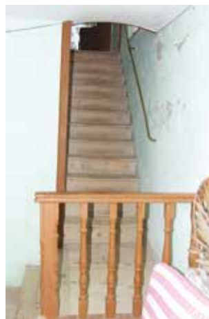
Slika 63. Jednokrako ugaono stepenište vodi na prostor prvog sprata
