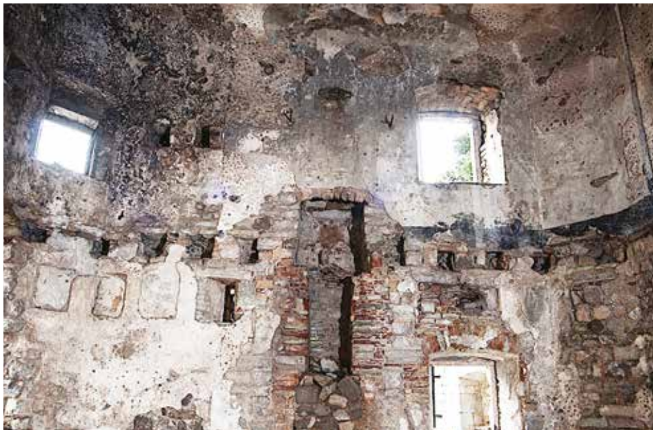
Слика 17. Положај лежишта за греде међуспратне конструкције изнад првог спрата
