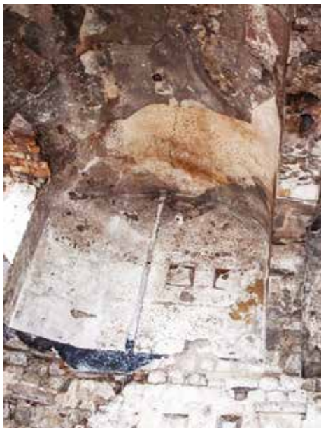
Слика 11. Вишеструки слојеви малтера разликују се по саставу и боји Слика 12. Оштећени фасадни малтер местимично открива изворну фасаду од камена
