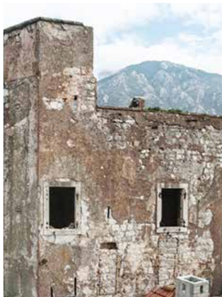
Слика 11. Вишеструки слојеви малтера разликују се по саставу и боји Слика 12. Оштећени фасадни малтер местимично открива изворну фасаду од камена
