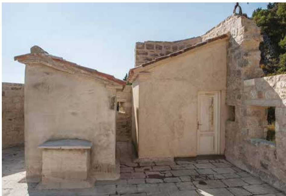
Изглед дијела кровне терасе (фотографија изведеног стања)
