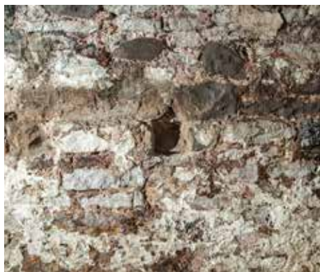
Слика 15. Удубљења за угаоне греде таванице изнад приземља
