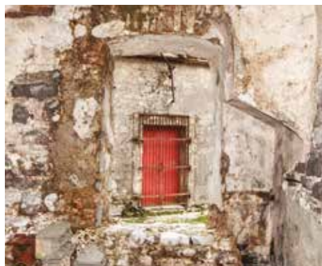
Слика 7. Накнадни прозорски отвор из аустроугарског периода на источној фасади
