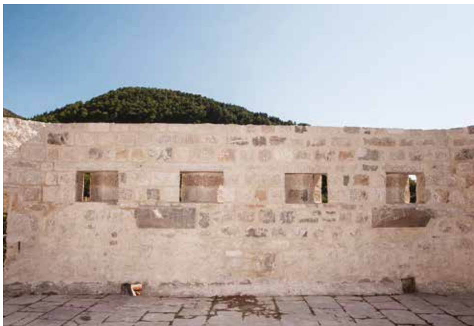
Изглед дијела кровне терасе (фотографија изведеног стања)
