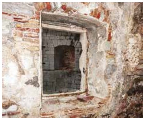
Слика 7. Накнадни прозорски отвор из аустроугарског периода на источној фасади
