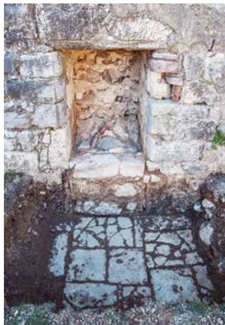
Слике 18. Изглед зазиданог отвора степеништа у своду куле Слика 19. Изглед зазиданих врата за улаз у приземље
