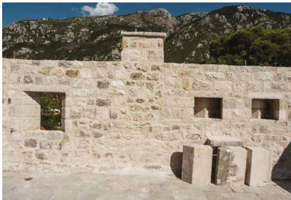
Изглед дијела кровне терасе (фотографија изведеног стања)
