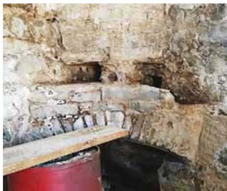
Слика 15. Удубљења за угаоне греде таванице изнад приземља
