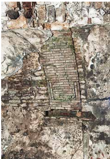
Слике 18. Изглед зазиданог отвора степеништа у своду куле Слика 19. Изглед зазиданих врата за улаз у приземље
