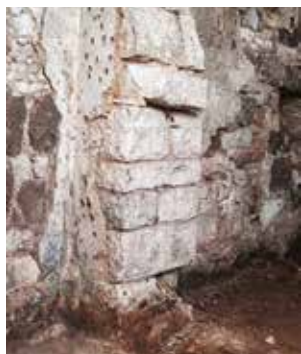
Слика 10. Потпорни лук угаоног закошења на југозападном углу куле
