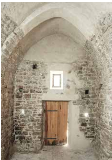
Слика 19. Стање цркве након радова изглед унутрашњости западног зида
