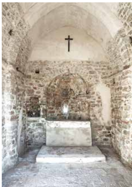
Слика 18. Стање цркве након радова изглед унутрашњости источног зида
