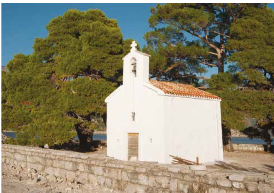
Слика 15. Стање цркве након радова – поглед са сјевероистока
