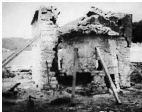
Слика 9. Изглед западног зида цркве након земљотреса 1979. г.
