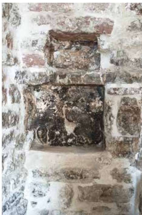
Слика 21. Стање цркве након радова – новооткривена ниша на источном зиду
