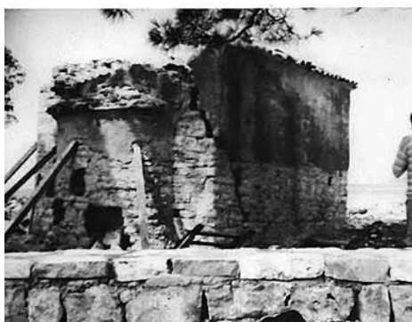
Слика 10. Изглед источног и сјеверног зида цркве 1979. г.
