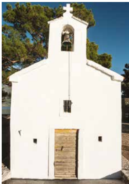
Слика 16. Стање цркве након радова изглед западне фасаде
