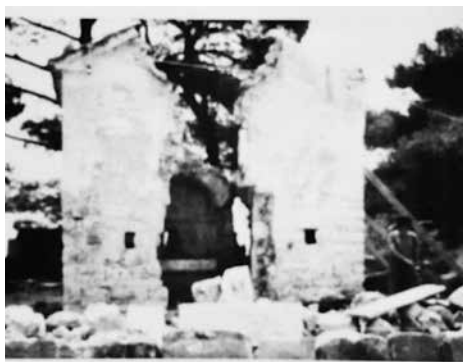
Слика 8. Изглед западног зида цркве након земљотреса 1979. г.
