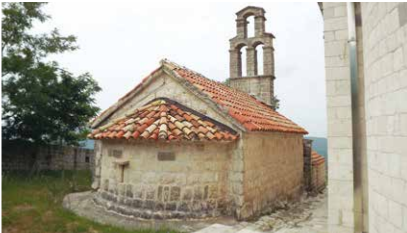
Слика 1. Црква Св. Николе, Пелиново - поглед са сјевероистока (снимила З. Чубровић)
