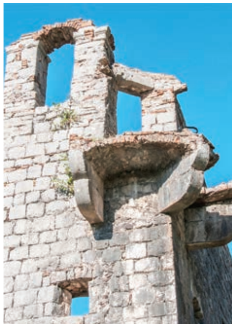
Слика 26. Остаци масивних конзола и сводова четвртастих кула на угловима каштела, надвишење "звоника" у опеци, испод мања угаона топарница првобитног опуса
