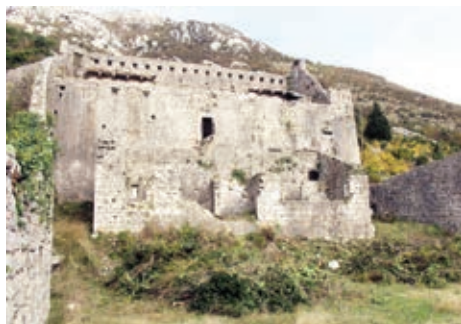
Слика 38. Касарна саграђена испред слободностојећег степеништа које води на покретни мост
