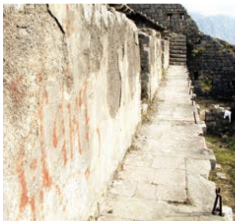
Слика 21. Детаљ поплочања шетнице од црвеног и сивог камена које више не постоји in situ
