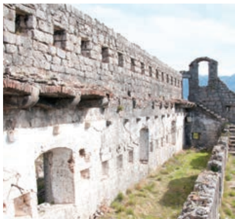
Слика 20. Квартир за војнике са накнадним пробијеним прозорима, малтерисан и окречен изнутра и споља
