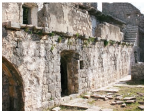
Слика 18. Зазидане аркаде, изнад детаљ камених конзола
