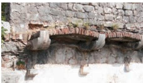
Слика 25. Детаљ конструкције одбрамбене шетнице, испод конзоле које су носиле кров касарне
