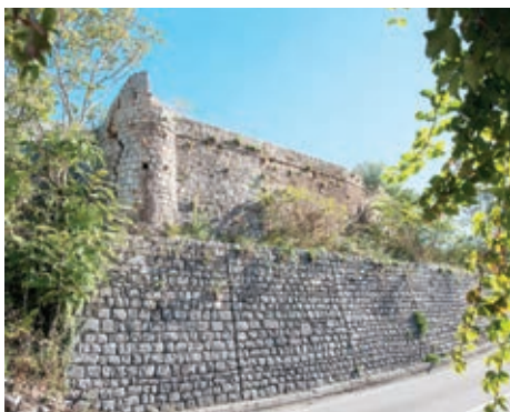
Слика 28. Детаљ западног бастиона
