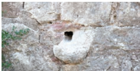
Слика 11. Жељезни покретни мост док је био у функцији, изнад отвор за повлачење ланца који је подизао мост
