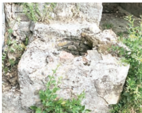
Слика 19. Круна бунара зидана од ситног камена и опеке
