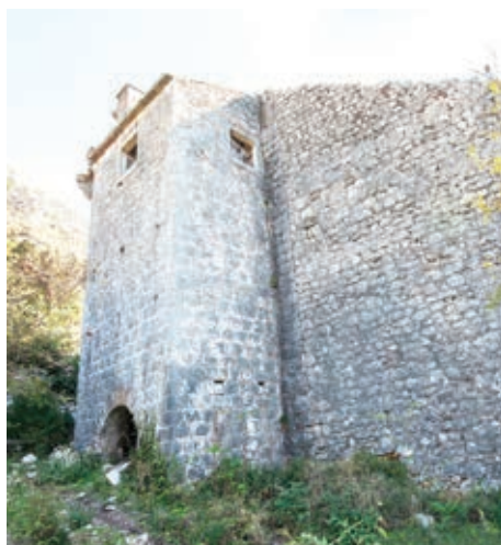
Слика 17. Анекс у функцији тоалета дограђен уз западну фасаду тврђаве
