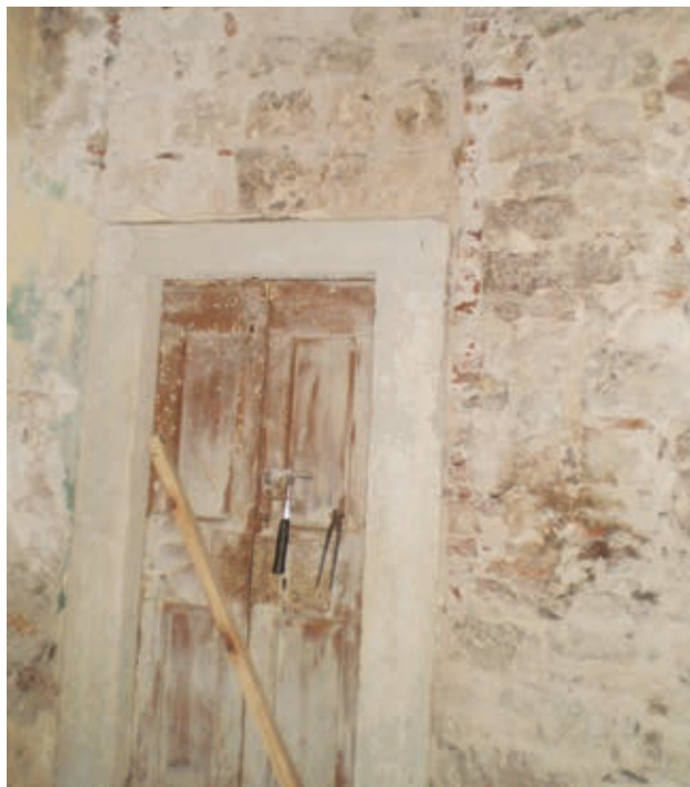
Fot. 17. Vrata koja iz crkve vode u zvonik
