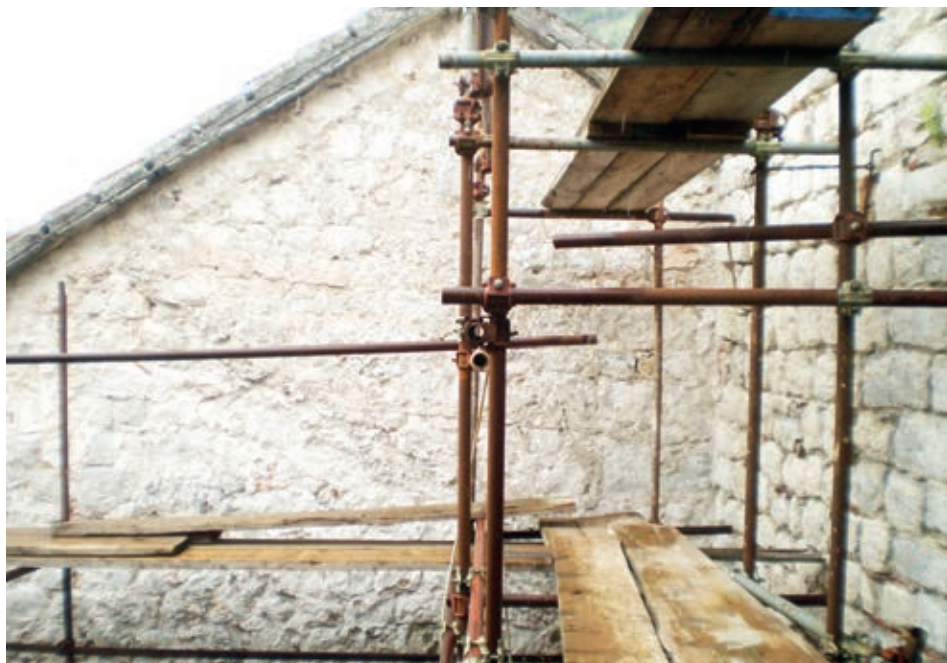
Fot. 12. Gornja zona južne fasade crkve sa kosinom krova starijeg samostana
