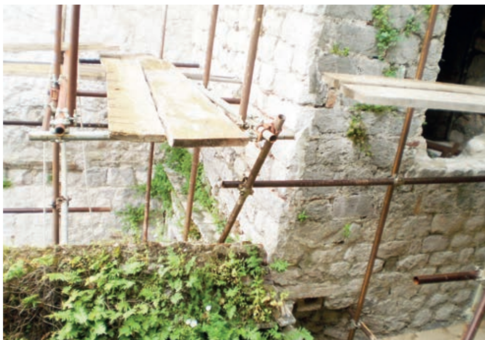
Fot. 13. Prisanjanje fasade zvonika na južni zid crkve - u visini II sprata zvonika
