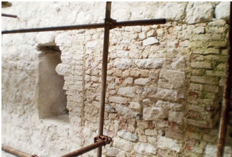
Fot. 14. Zazidani otvori i pregradnje na južnoj fasadi crkve, u visini horske galerije
