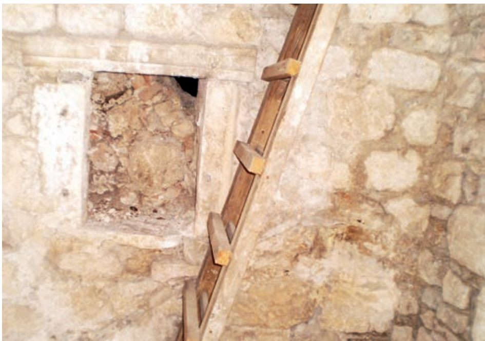
Fot. 16. Detalj tragova krova najstarije faze gradnje zvonika i poznijim prozorom na južnom zidu crkve
