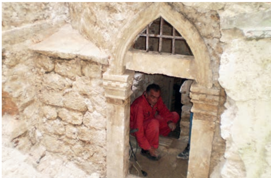
Fot. 9. Novootkriveni gotički otvor u prizemlju zvonika, južna strana
