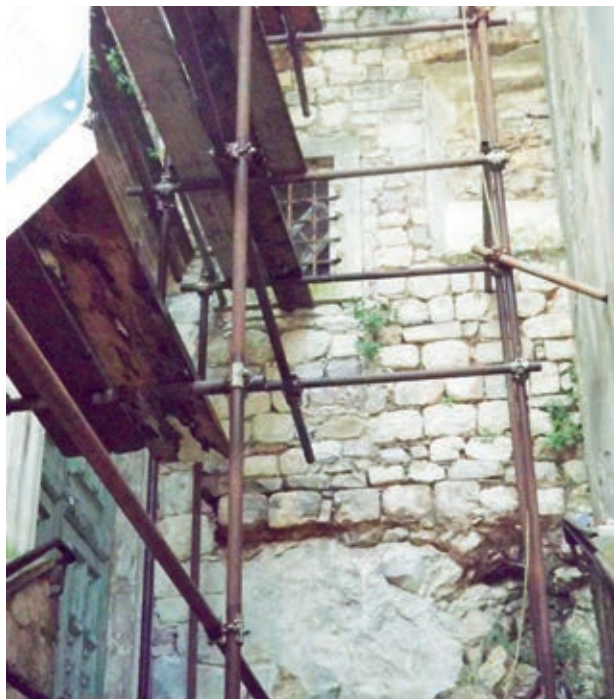
Fot. 5. Zapadna fasada zvonika – oslonac na prirodnoj stijeni i zona prizemlja
