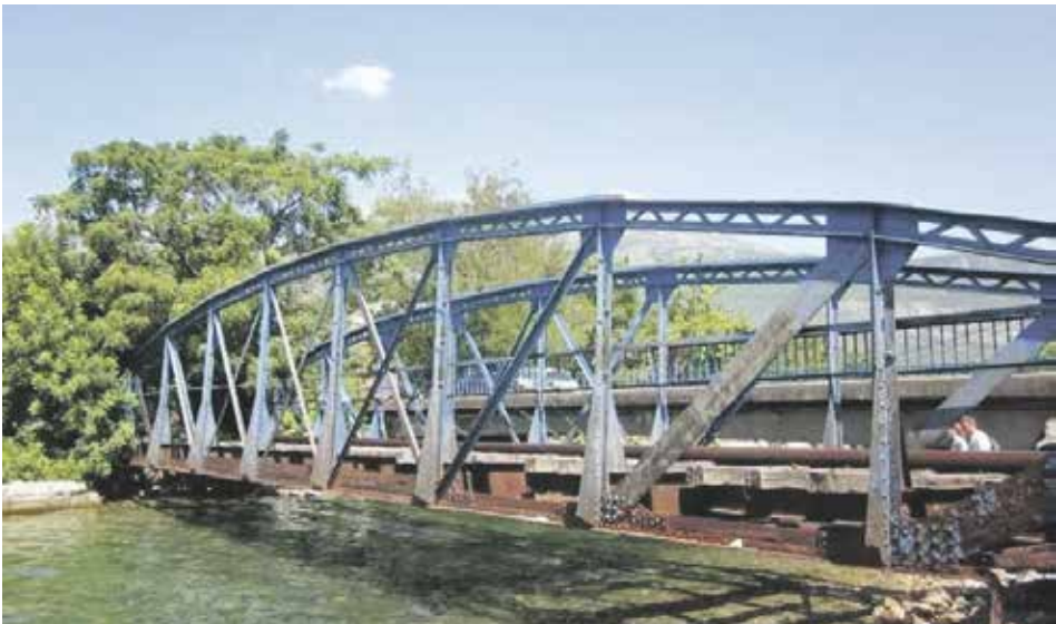
Слика 3. Изглед моста са низводне стране (старна Б)
