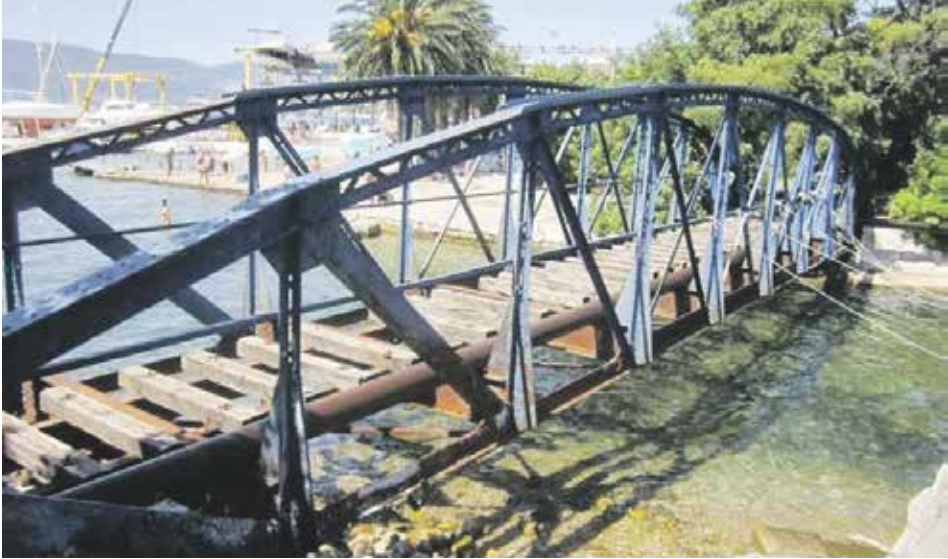
Слика 2. Изглед моста са узводне стране (старна А)
