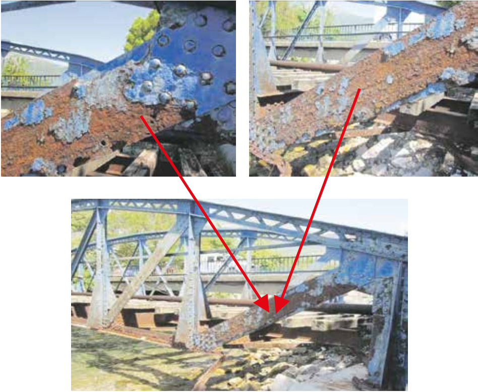
Слика 8, 9, 10. Дијагонала у првом пољу, страна Б; општа и површинска корозија; љускање заштитног премаза; рупе у лиму као последица израстите корозије
