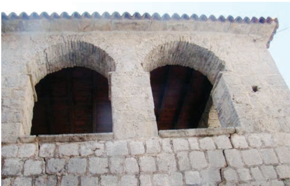
Sl. 4 Lođa Palate Visković, način zidanja lukova (I sprat)
