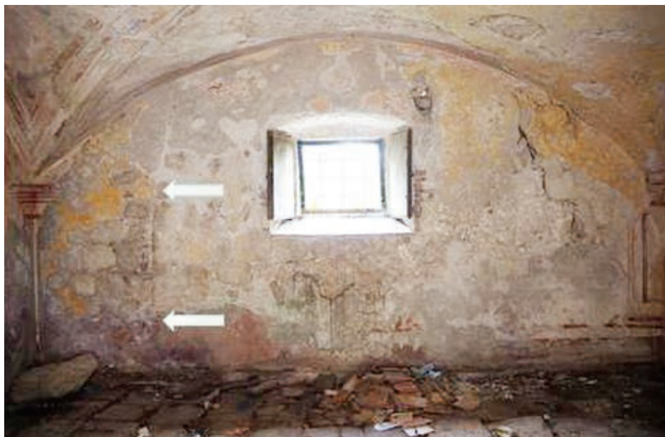
Sl. 2 Prizemlje lođe, južni zid, strelicama označen položaj zazidanih vrata, prvi sloj maltera preko zazidanog otvora je krečnopješčani malter koji je obojen rumenožutom bojom
