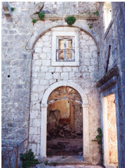
Zid sa ulaznim portalom kojim je naknadno zazidan prostor ispod ranijeg mosta (2019. g.)
