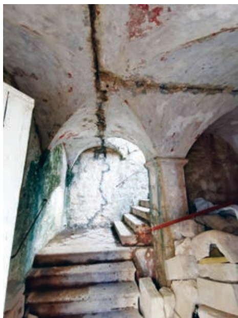
Pogled na unutrašnje stepenište u ulaznom holu koje iz prizemlja vodi na terasu u visini I sprata (2019. g.)
