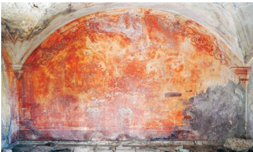
Izgled istočnog zida u prizemlju lođe sa ostacima slikane dekoracije (2019. g.)
