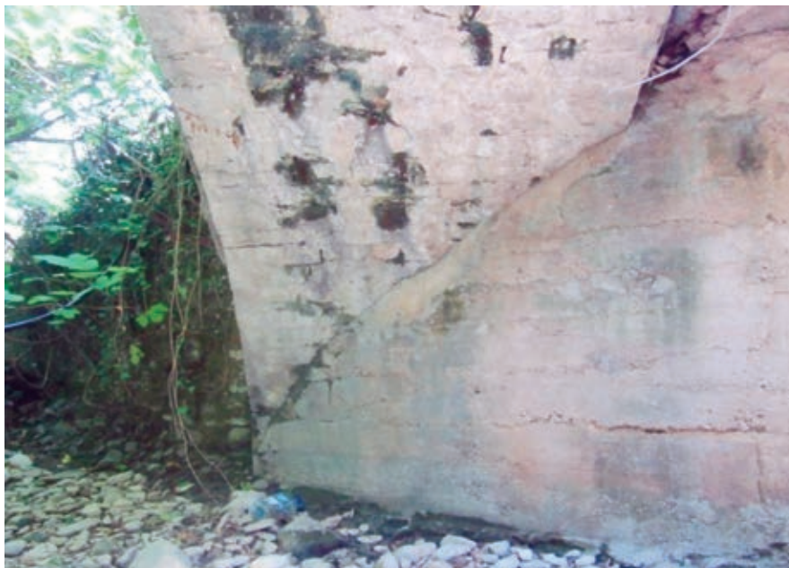
Сл. 7 Десни ослонац моста преко којег је навучен бетонски ослонац новог моста
