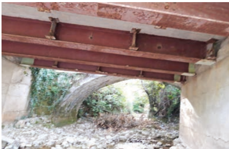
Сл.6 Изглед моста са низводне стране - дио лука затвара челична конструкција
