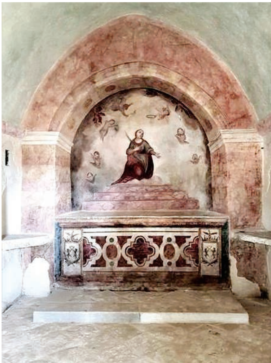
Sl. 3 Oltarska apsida, nakon izvedenih konzervatorsko-restauratorskih radova
