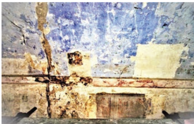
Sl. 10 Severni zid, venac i deo svoda, zatečeno stanje
