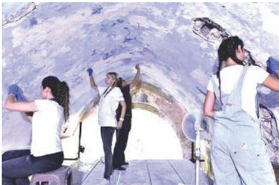
Sl. 16 Stručna konzervatorsko-restauratorska ekipa, rad na svodu crkve
