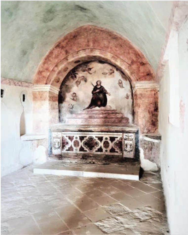
Sl. 21 Crkva Sv. Neđelje, stanje nakon konzervatorsko-restauratorskih radova
