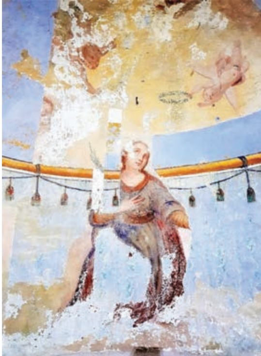
Sl. 18 Istočni zid, oltarska apsida, zatečeno stanje, detalj
