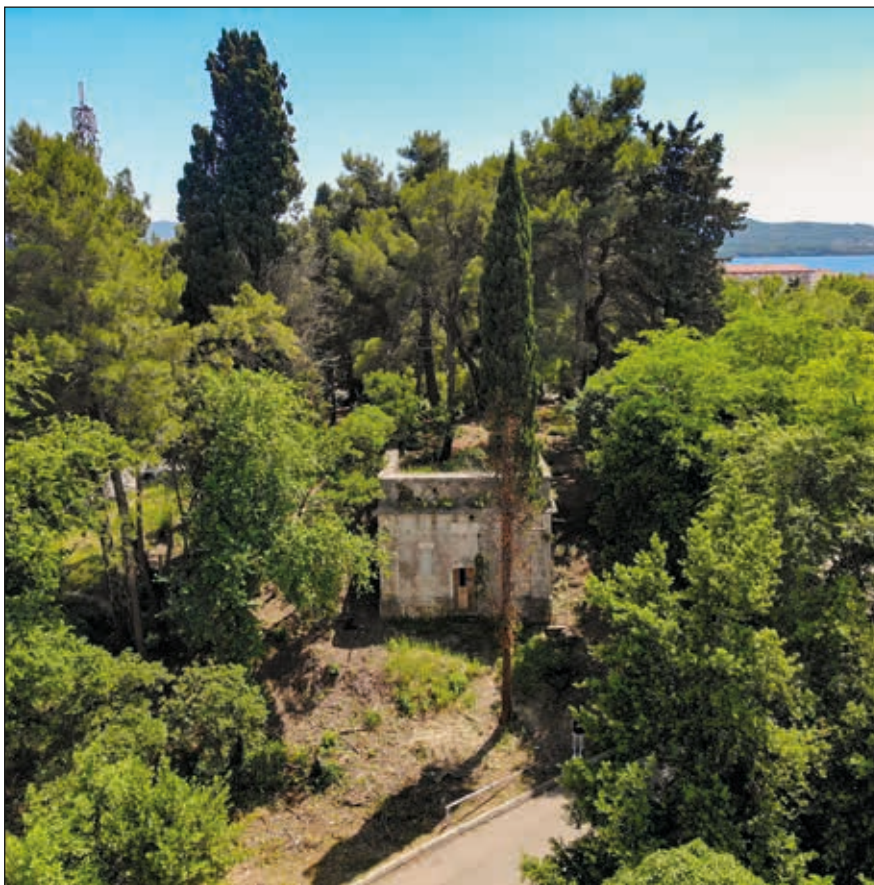
Sl. 6 | Fotografija zgrade nad rezervoarima, Studio Enforma 2023. godina / dron
