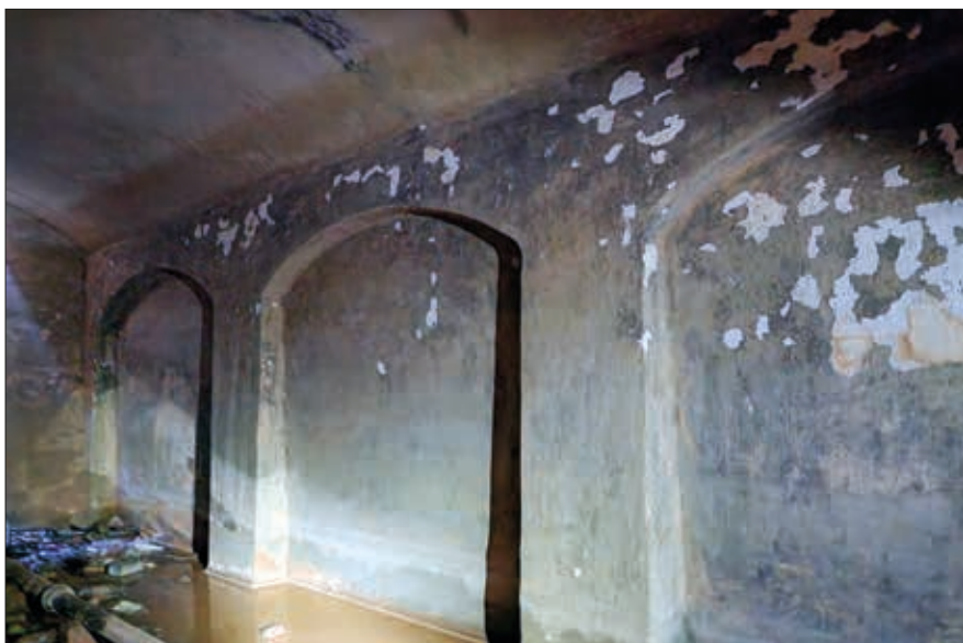
Sl. 8 | Fotografija unutrašnjeg dijela rezervoara zida ojačanog plitkim nišama, Studio Enforma , februar 2023. godina
