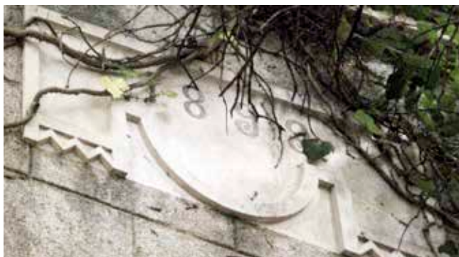
Sl. 1 | Natpis na glavnoj fasadi sa godinom izgradnje rezervoara (Studio Enforma, feb. 2023. godine)
