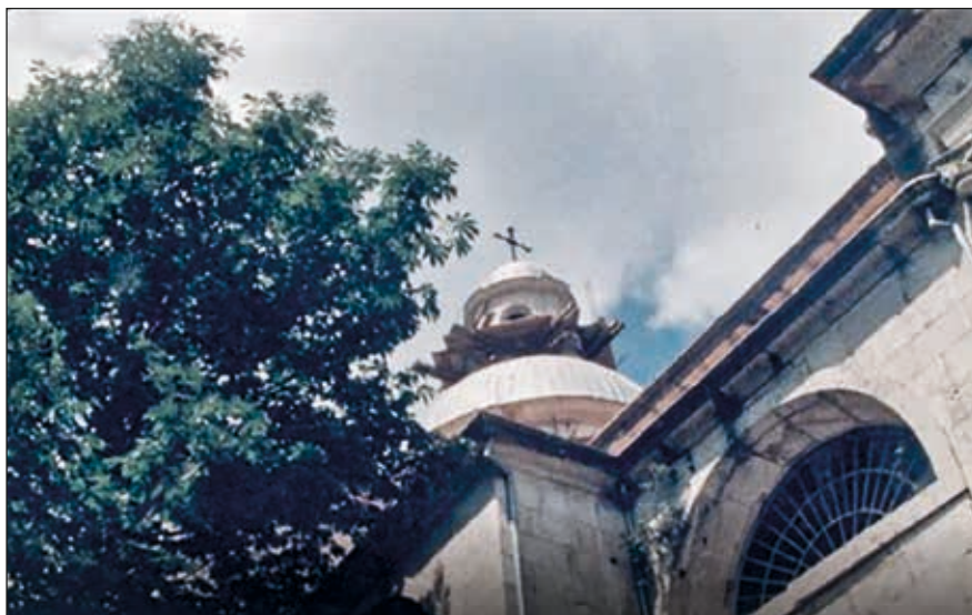
Sl. 3 | Pogled na kupolu i lanternu sa platformom konzolne skele
