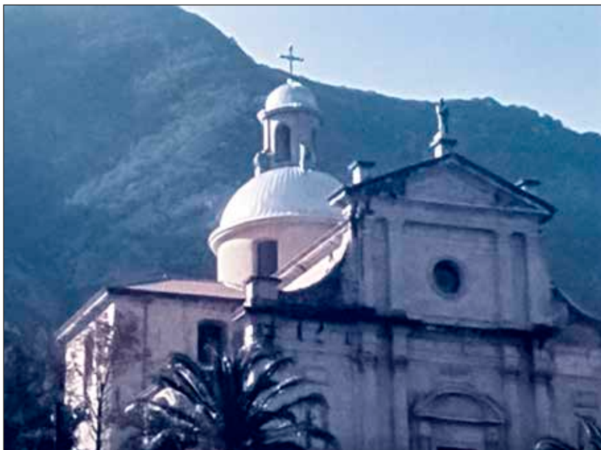
Sl. 1 | Pogled sa jugoistoka na kupolu i lanternu crkve – posle završetka radova
