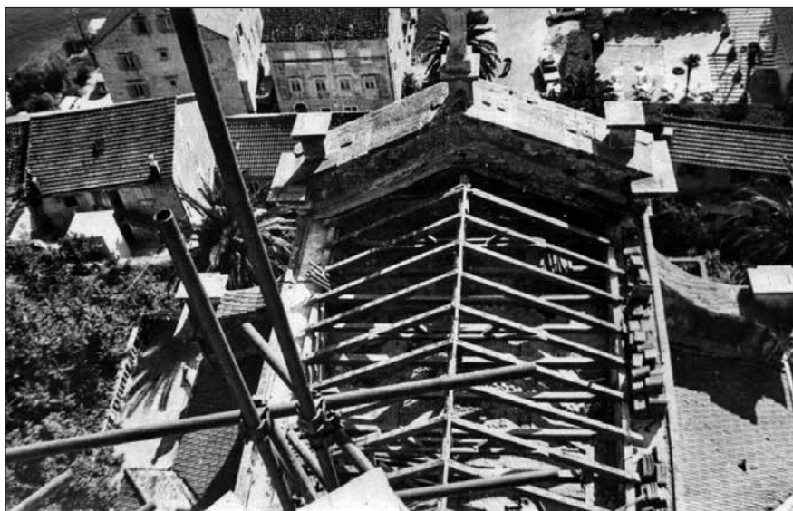
Sl. 12 | Krovna konstrukcija nad istočnim krakom glavnog broda – u toku radova
