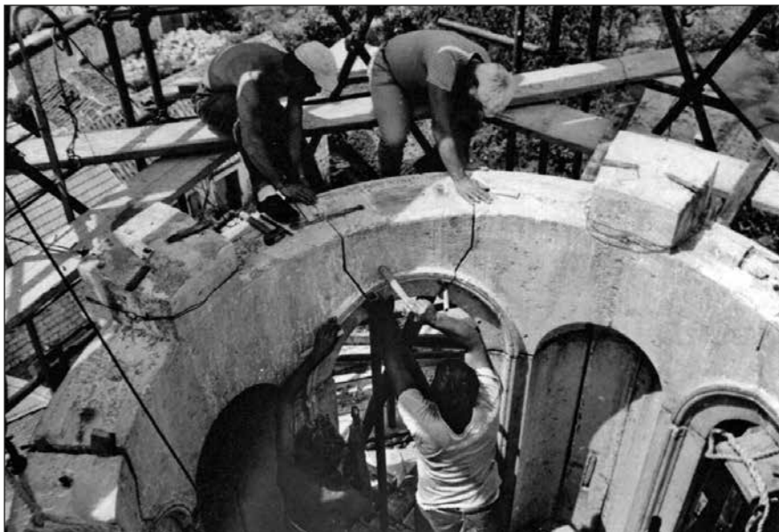
Sl. 6 | Demontaža bloka koji se nalazi u tjemenu luka iznad prozora
