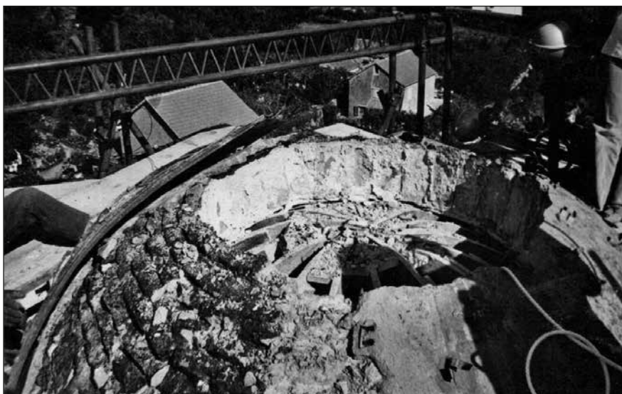
Sl. 5 | Pogled na kalotu lanterne u toku njene demontaže
