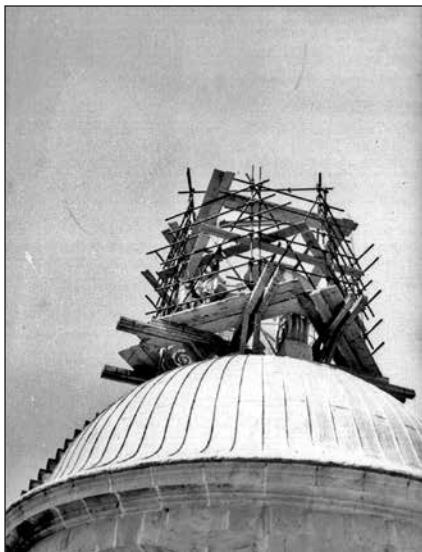
Sl. 4 | Pogled sa jugozapada na krov kupole i skelu oko lanterne
