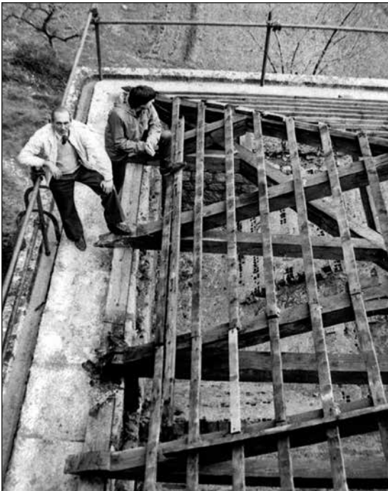
Sl. 13 | Krovna konstrukcija nad sjevernim dijelom transepta – u toku radova. U uglu fotografije je arh. Đokan Biskupović, nadzorni organ (lijevo)
