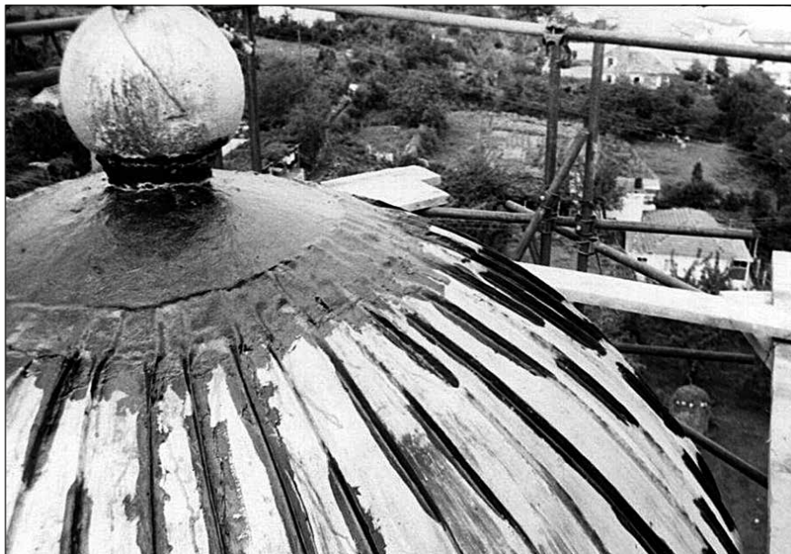
Sl. 10 | Postolje krsta nakon postavljanja krovnog pokrivača lanterne
