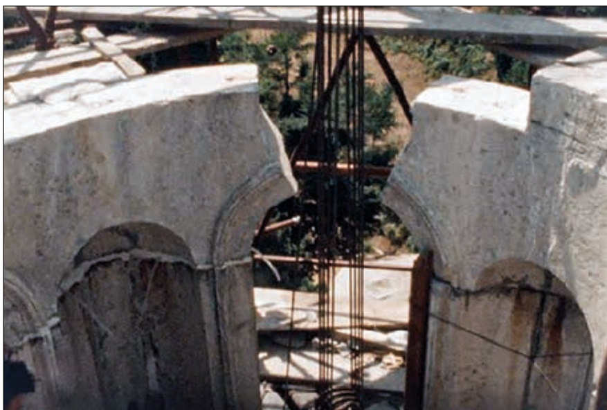
Sl. 7 | Pogled na unutrašnjost lanterne nakon demontaže bloka koji se nalazi u tjemenu luka prozorskog otvora
