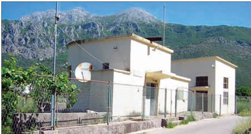
Сл. 2.3.1. Објекат пумпне станице Опачица, на врелу Опачица, са управном и машинском зградом
