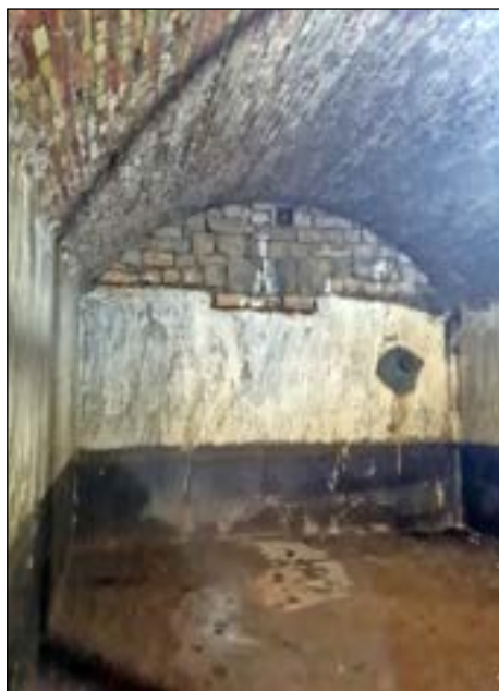
Sl. 5 | Fotografija rezervoara za vodu uz tvrđavu, nakon snimanja i čišćenja, 2025. godina
