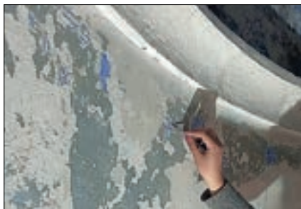
Sl. 21 | Sondažna ispitivanja slikane dekoracije u tamburu ispod venca
