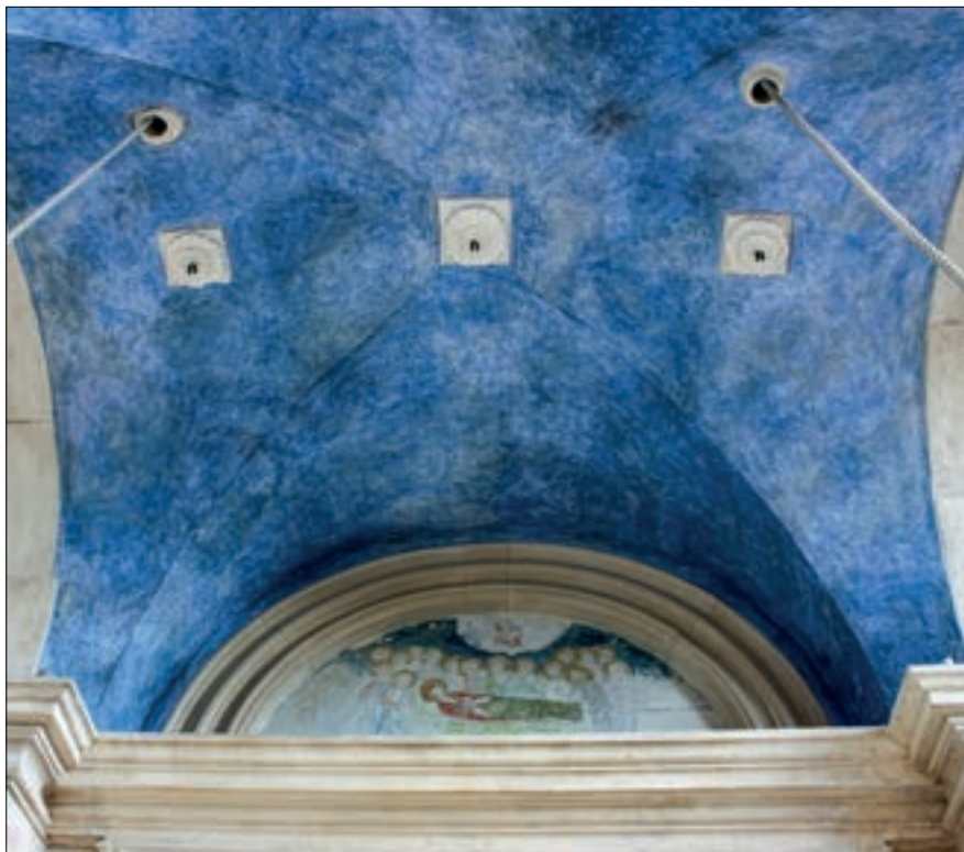
Sl. 28 | Pogled na krstasti svod zvonika, nakon radova
