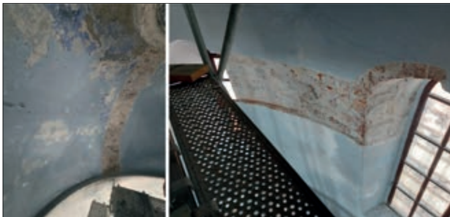
Sl. 19 a,b | Sondažna ispitivanja kupole i tambura
