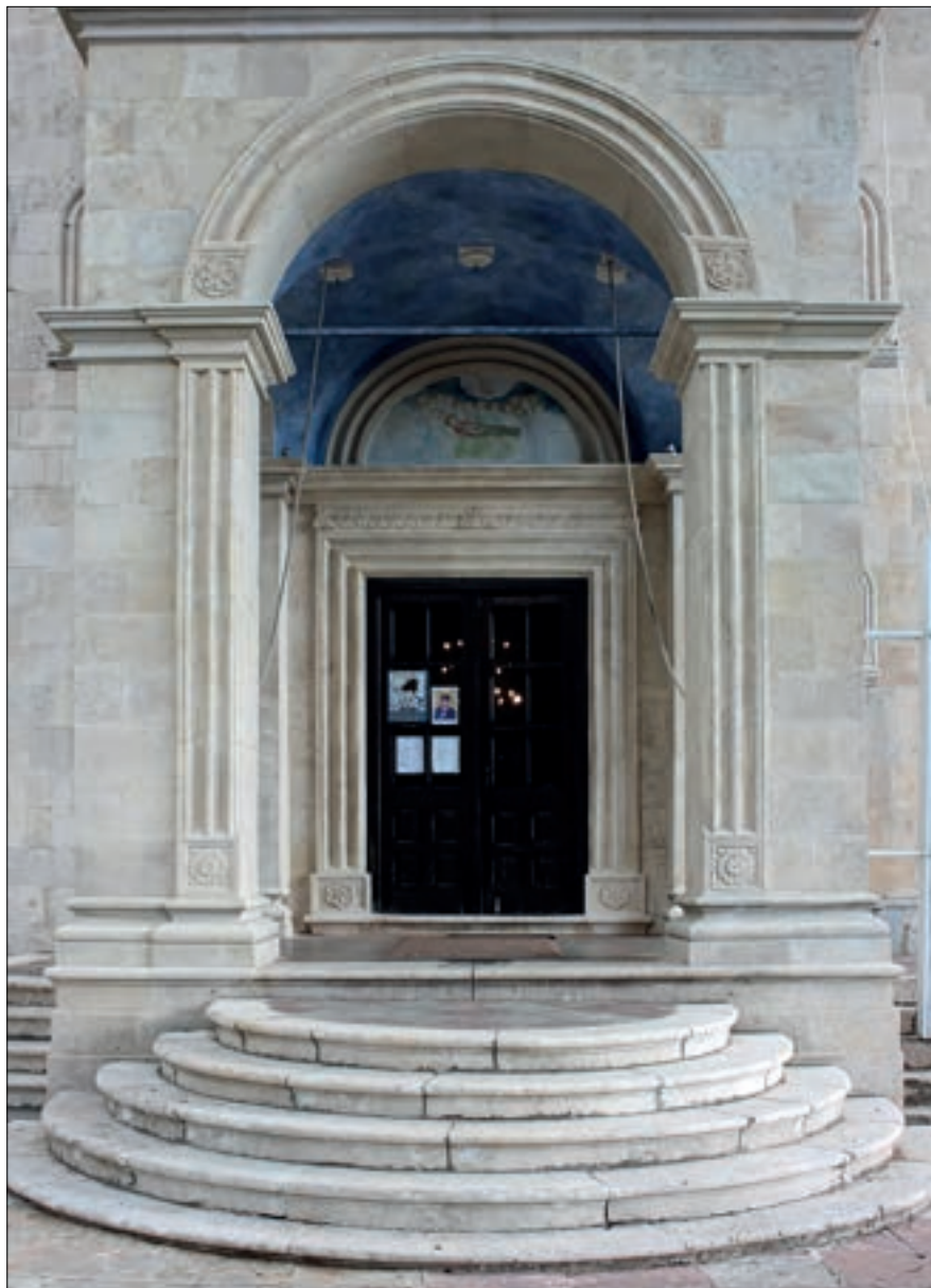
Sl. 25 | Zvonik, prizemlje, glavni ulaz u crkvu, nakon radova
