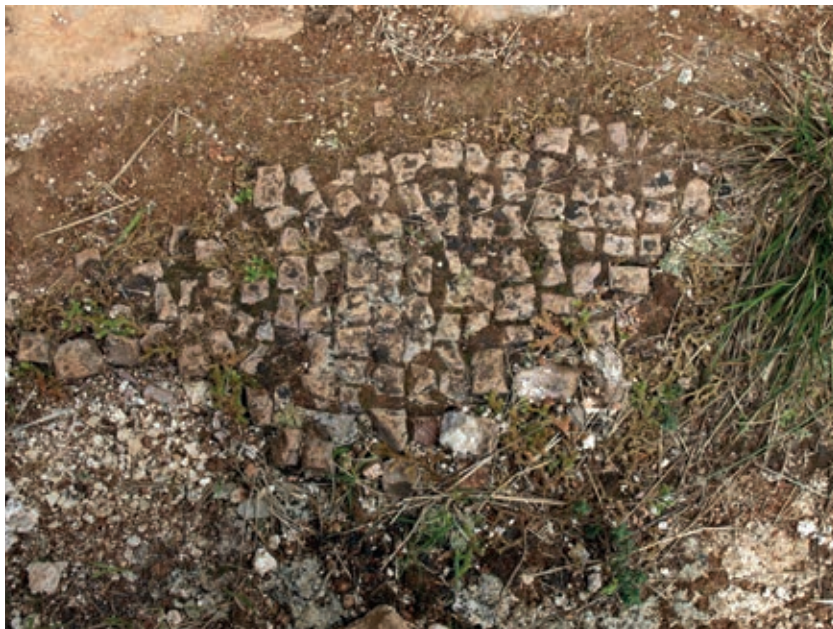
Sl.12 - detalji oštećenja mozaika
