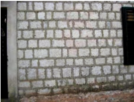
Izgled recentnih kaišastih spojnica na glavnoj i fugovanih na bočnoj fasadi
