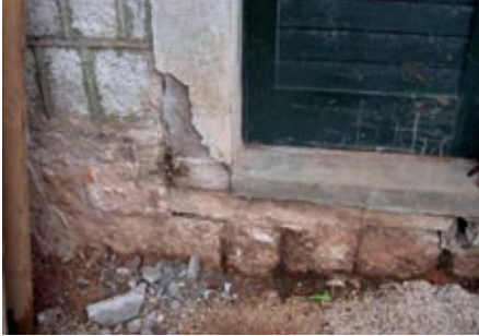
Izgled malterne sonde na glavnim vratima
