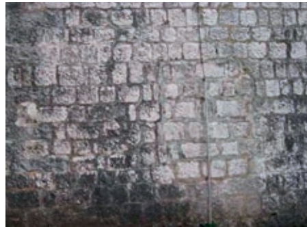
Izgled recentnih kaišastih spojnica na glavnoj i fugovanih na bočnoj fasadi
