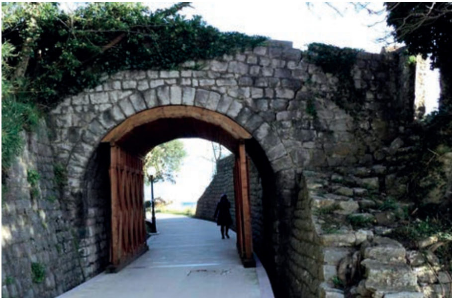
Слика 5. Изглед моста 2012. године, непосредно прије санације, са дрвеном оплатом
