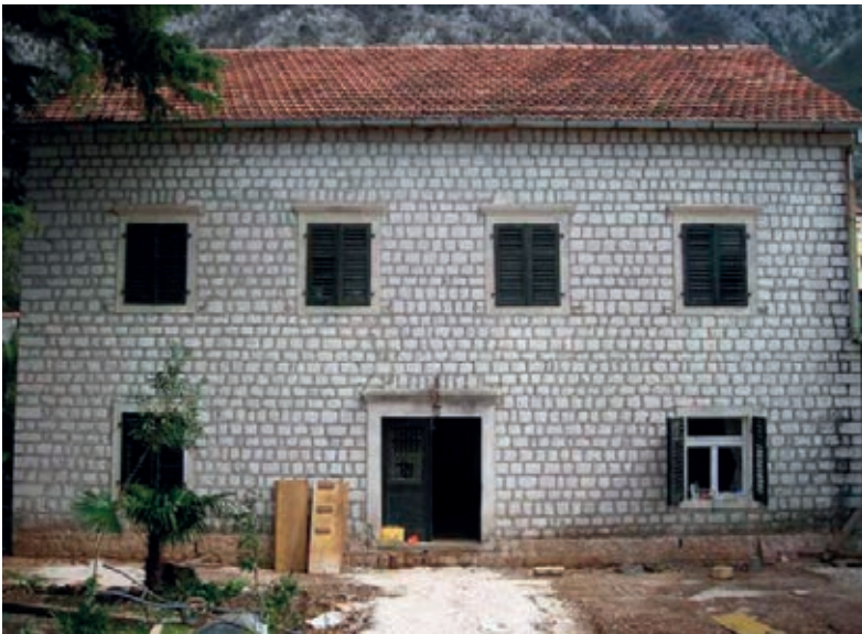
Izgled glavne fasade placina
