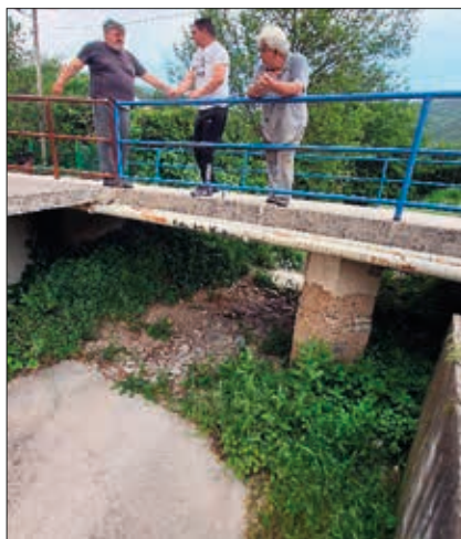
Сл. 2.1.6. Мост на Манитовцу
