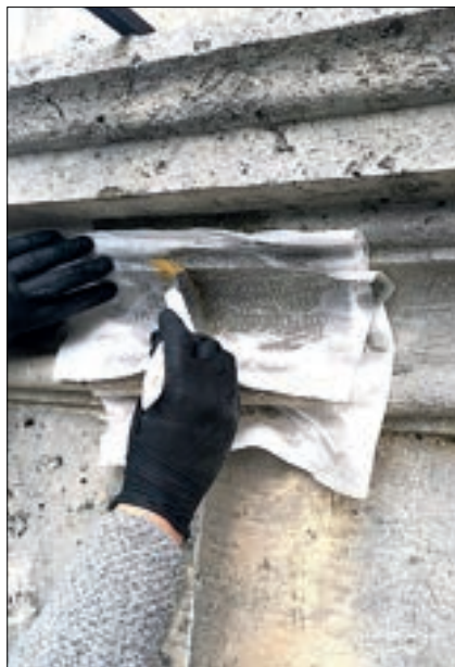
Sl. 24 | Proces čišćenja kompresama, kameni venac zvonika
