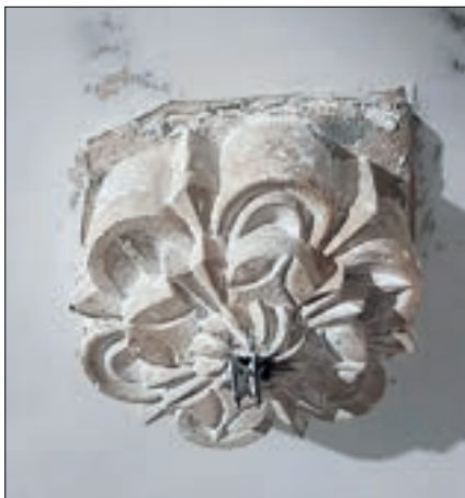
Sl. 17 | Kapitel kolonete, nakon radova
