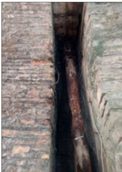
Sl. 33 | Drveno vitlo u svodu Dejan Palibrk, privatna arhiva, snimljeno 2018. godine
