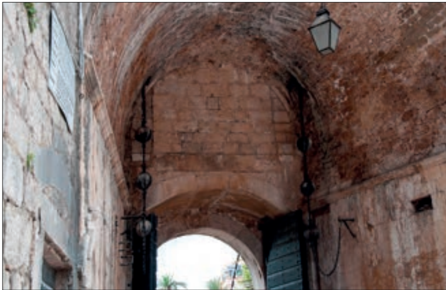
Sl. 20 | Fotografije detalja mostova u Dubrovniku – Vrata od Pila (Dejan Palibrk, privatna arhiva, snimljeno 2018. godine)
