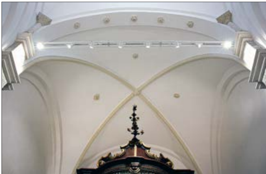
Sl. 5 | Svod u zapadnom traveju, nakon radova
