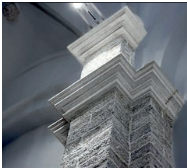
Sl. 7 | Pilastar sa profilisanim vencima nakon radova
