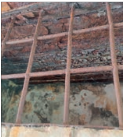
Sl. 34 | Metalne čelične rešetke kojima je zatvoren dio niše u zidu
