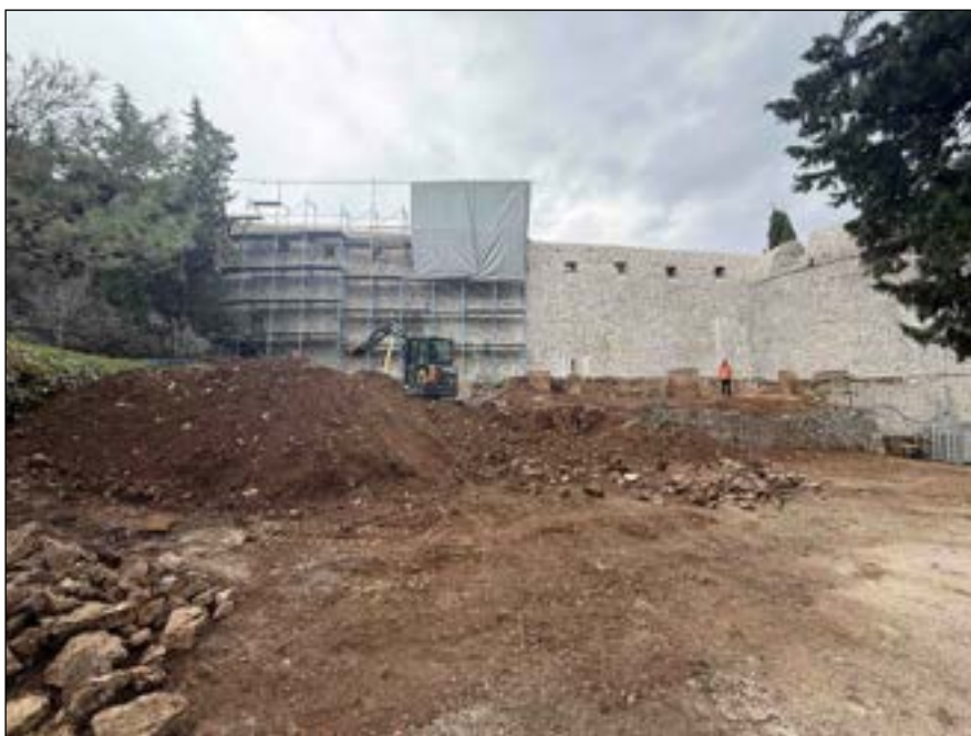
Sl. 5 | Fotografija tokom izvođenja radova i čišćenja lokacije uz SI rondelu i postojeći rezervoar za vodu uz tvrđavu, oktobar 2025. godina.
