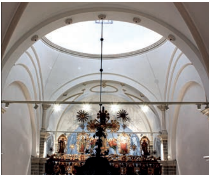
Sl. 14 | Pogled sa zapada na podnožje tambura sa kolonetama u uglovima, nakon radova
