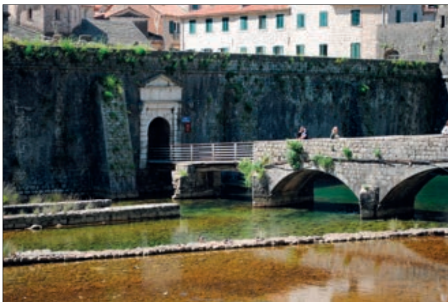
Sl. 28 | Pogled na današnje stanje mosta i ulazne sjeverne kapije Dejan Palibrk, privatna arhiva , snimljeno 2025 godine
