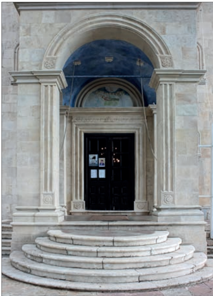
Sl. 25 | Zvonik, prizemlje, glavni ulaz u crkvu, nakon radova
