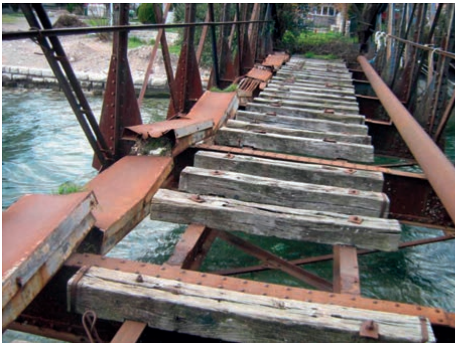
Мост „Зеленика”, приказ преосталих металних и дрвених дјелова некадашњег моста и елемената пруге, који су остали од демонтаже из 1968. године
