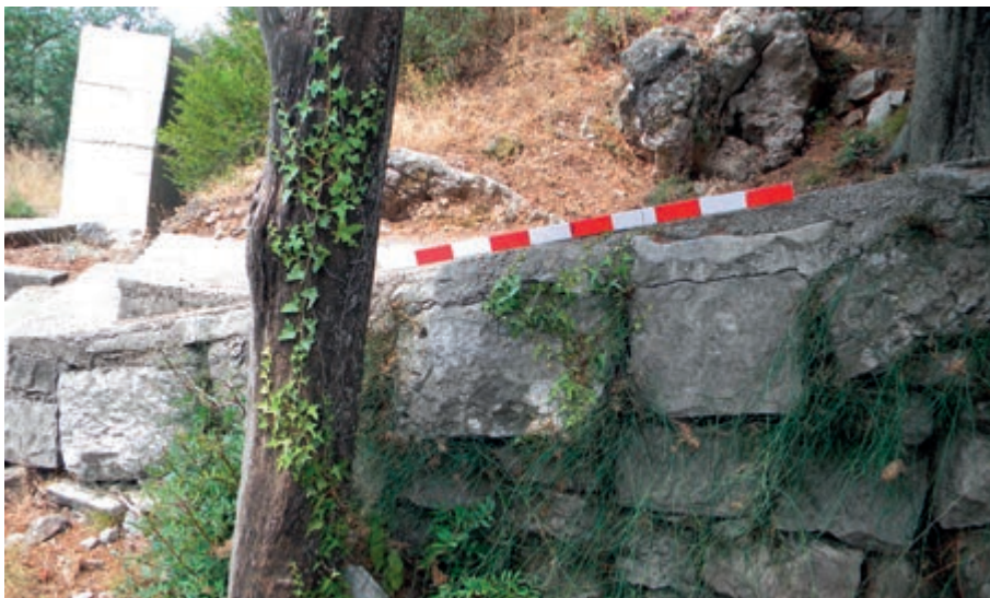
Слика 4 Квадери у супструкцији у секундарној употреби (фотографисао М. Д.)
