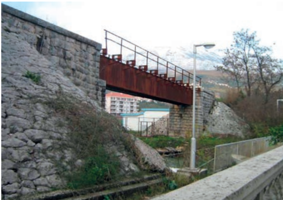
Мост на ријеци Суторини
